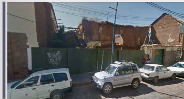
Vacios urbanos Dos lotes de viviendas colapsadas
