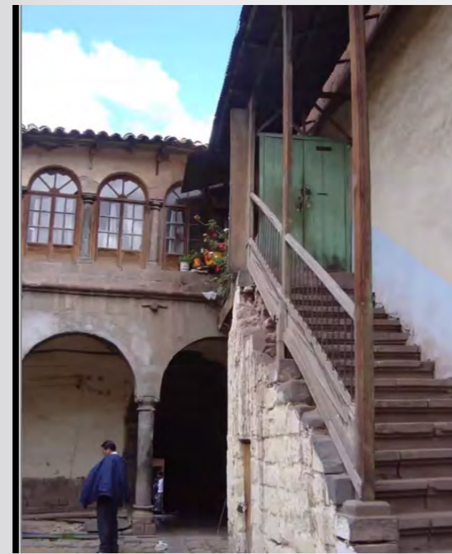
Galería del patio interior de vivienda
