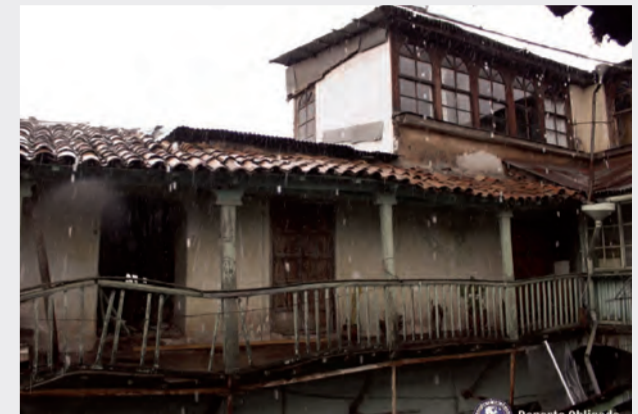
Estado Actual de las galerías de vivienda
