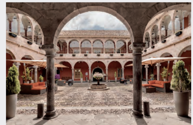
Patio principal del inmueble transformado en patio de hotel.
