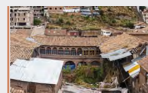
Patio de vivienda con construcciones precarias al interior
