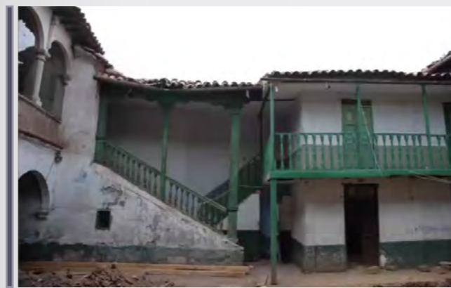
Interior del patio de vivienda
