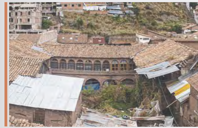
Patio compartido de vivienda con construcciones precarias al interior
