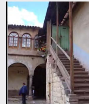
Galería del patio interior de vivienda
