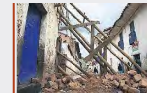
Puntales para frenar el colapso de la fachada de vivienda.
