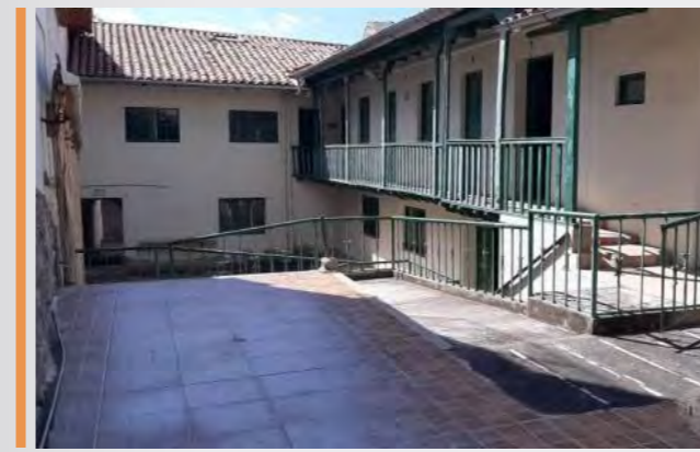
Patio interior de vivienda con pisos y muros en condición aceptable.
