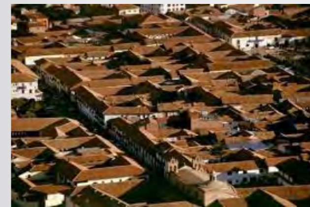
Tejido urbano de un Centro que no supera los dos niveles
