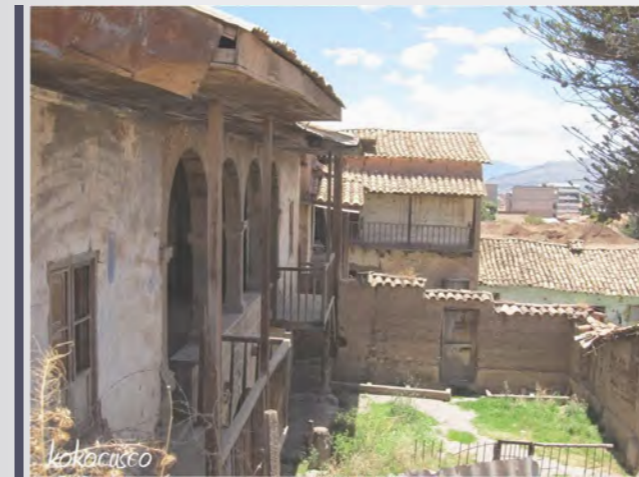
Condición actual del patio interior de vivienda
