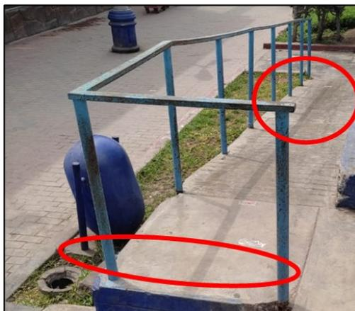
**Figura 23** Baranda de una rampa sin extensión de tramo horizontal en los extremos y sin pasamanos adicionales a diferente nivel
