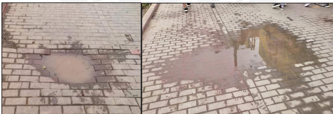
**Figura 10** Empozamiento de agua en superficie de adoquines
