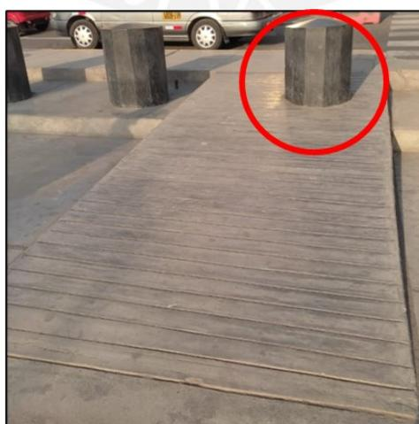
**Figura 11** Obstáculos que reducen el ancho efectivo de rampas en el entorno peatonal analizado
