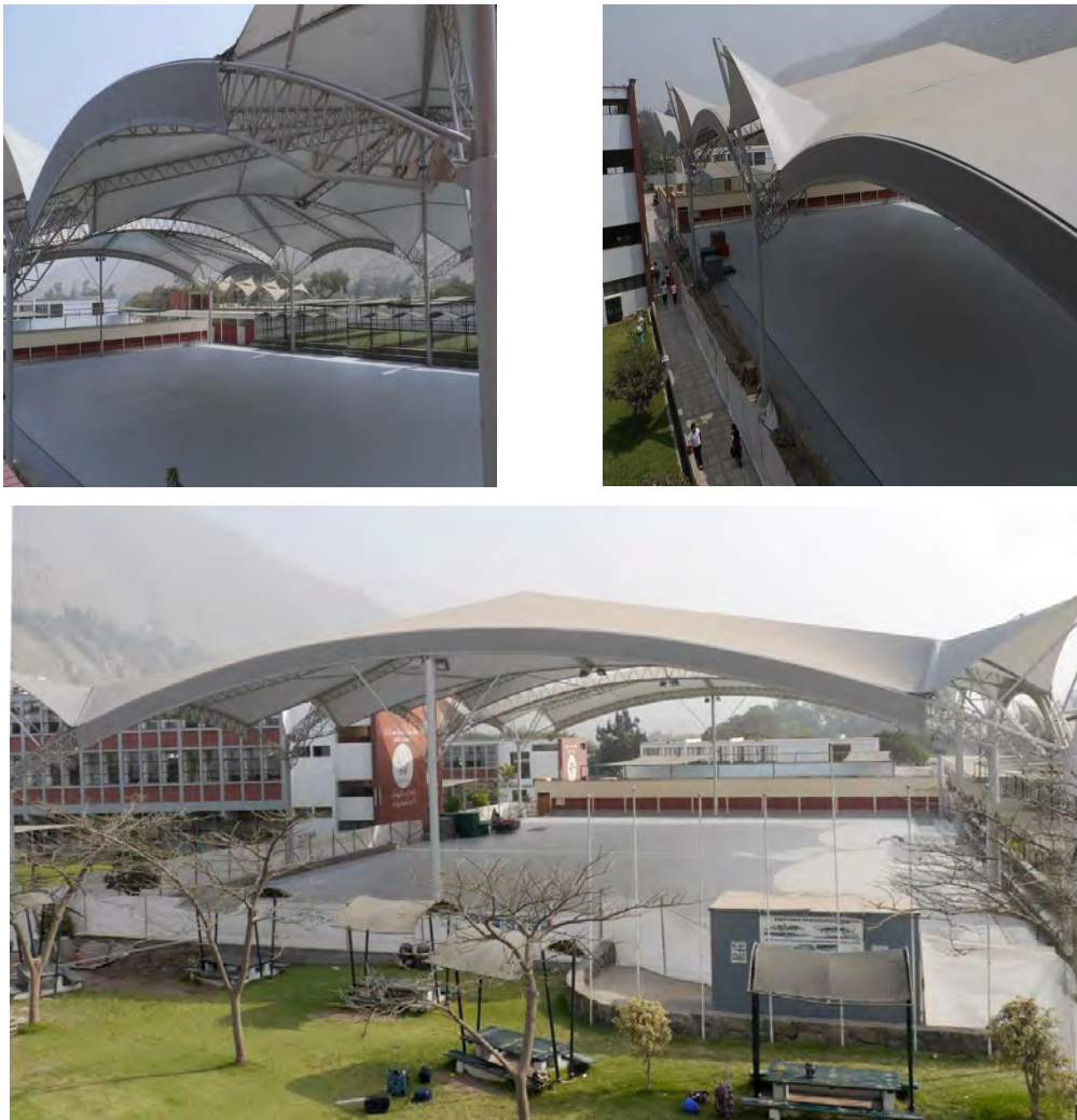
Figura 1-2. Construcción con armaduras tubulares en Chosica – Perú. Fuente propia.
