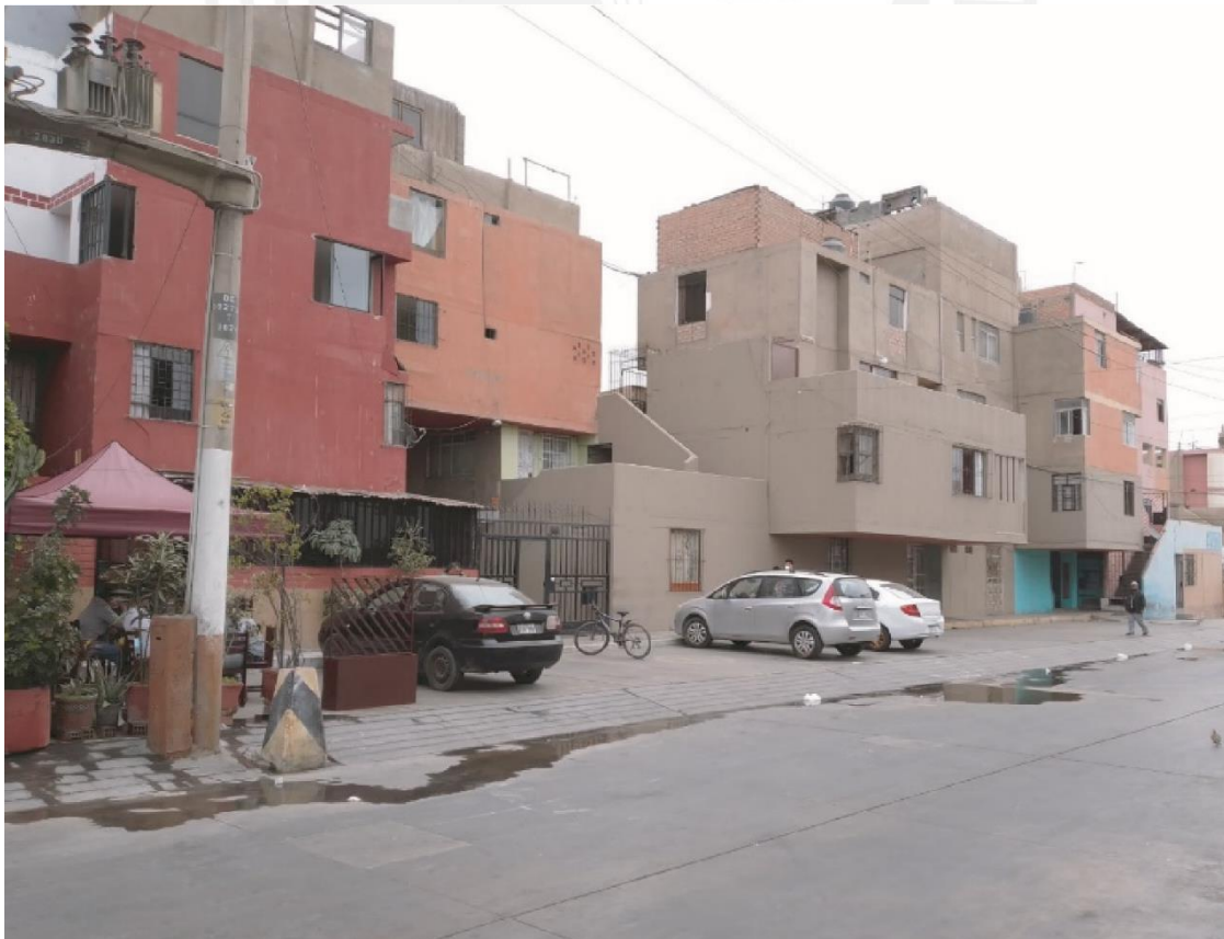
Fig. 14. Comparación antes y después del Conjunto de viviendas en el Callao, Fachada del Sector A. Fuente: Catálogo de Arquitectura Moderna, 8 de diciembre de 2021, captura de 1971; fotografía tomada por el autor en octubre de 2021.
