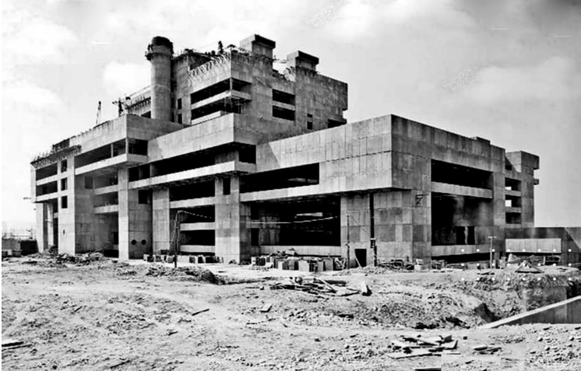
Fig. 3. Ministerio de Pesquería en construcción con el material predilecto del equipo Mazuré-Cruchaga – Soyer: el concreto armado. Fuente: GEC Archivo Histórico.
