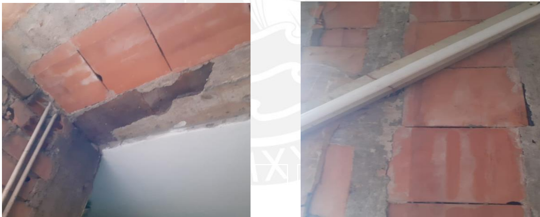
Figura 4.14: Techo del tercer piso (Fuente: propia)
