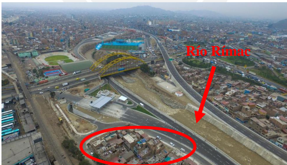
Figura 4.8: Cercanía entre la vivienda y el Río Rímac (Perú 21, 2018)
