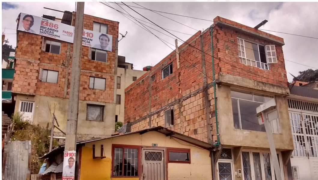
Figura 1.2: Viviendas autoconstruidas de albañilería confinada (Google,2015)
