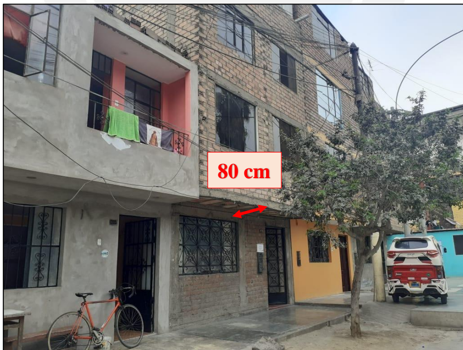
Figura 4.11: Volado de 80 cm en los niveles superiores (Fuente: propia)
