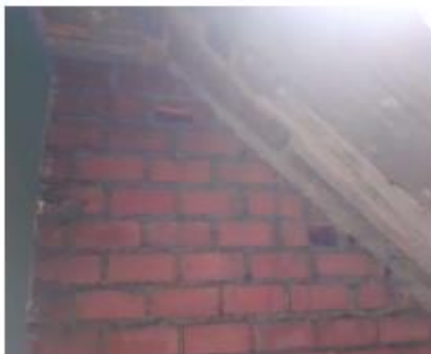
Inadecuado asentado de ladrillos
