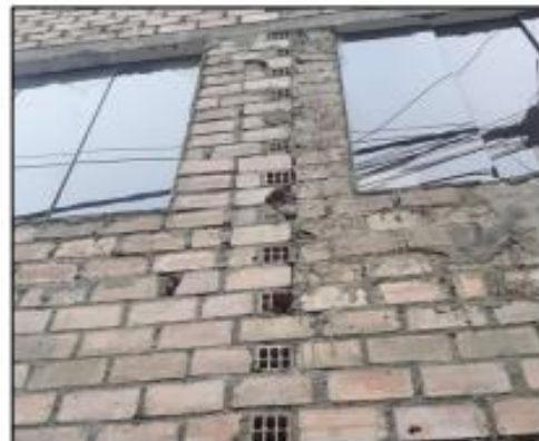
Inadecuado asentado de ladrillos
