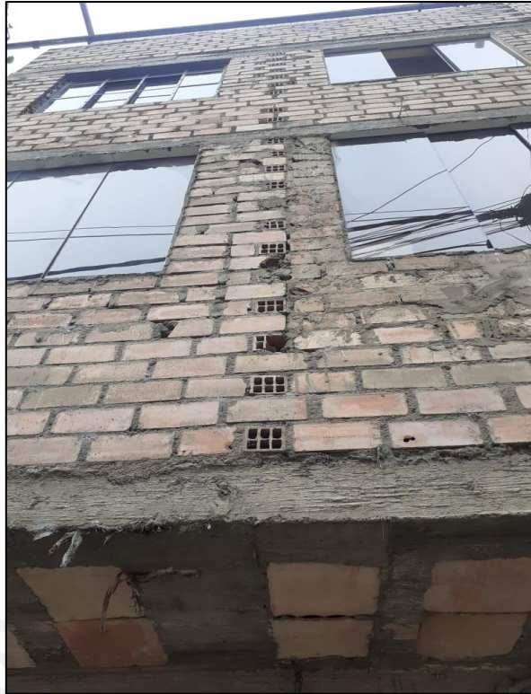
Figura 4.10: Uso de ladrillos pandereta en el piso 2 y 3 (Fuente: propia)
