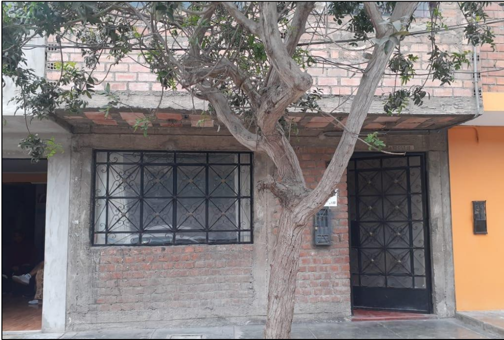
Figura 4.12: Fachada del primer piso (Fuente: propia)
