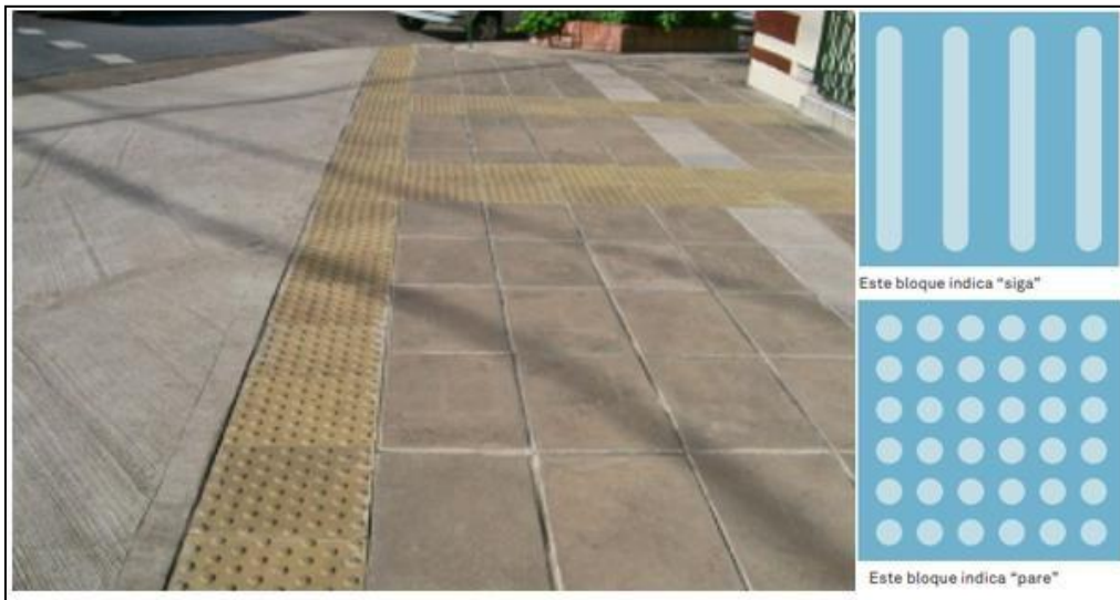
Figura 8 Ejemplo de superficie podo-táctil
