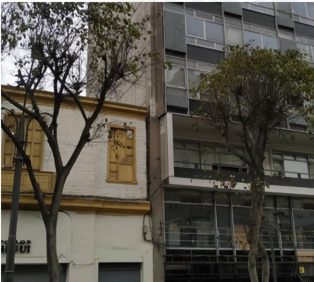
Detalle de fachada en Av. Nicolás de Piérola. Se observa la coincidencia de la arista inferior del volumen de la torre y la altura de la construcción vecina. Fotografía propia.
