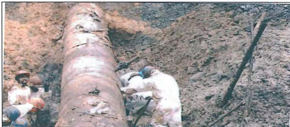
Foto 12: Vista cercana de zona de la tubería por donde fugaba el petróleo crudo, se observa una plancha metálica soldada a la tubería con un tapón y una válvula de 2\"
