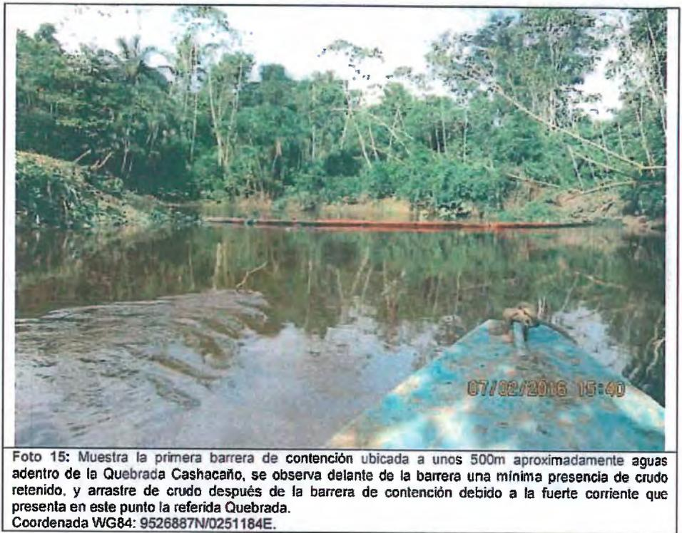
Foto 15: Muestra la primera barrera de contención ubicada a unos 500m aproximadamente aguas adentro de la Quebrada Cashacaño, se observa delante de la barrera una mínima presencia de crudo retenido, y arrastre de crudo después de la barrera de contención debido a la fuerte corriente que presenta en este punto la referida Quebrada.
