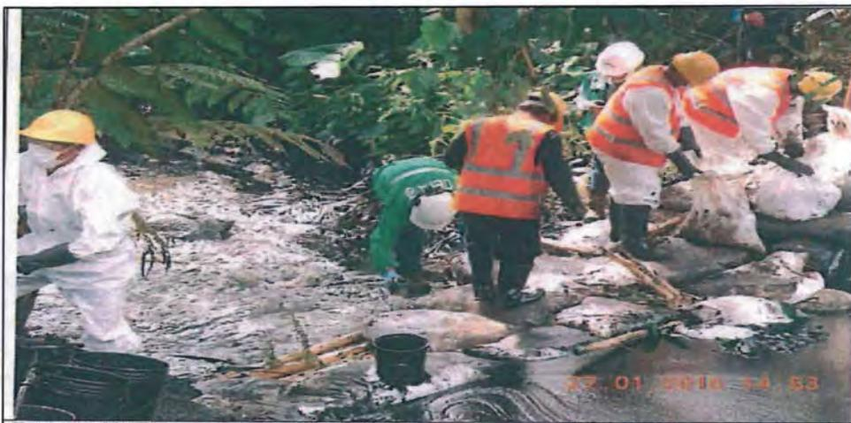
Foto 07: Muestra a personal por parte de la empresa PETROPERU instalando barreras de contención en el cauce de la quebrada Inayo, aguas abajo del punto del derrame.
