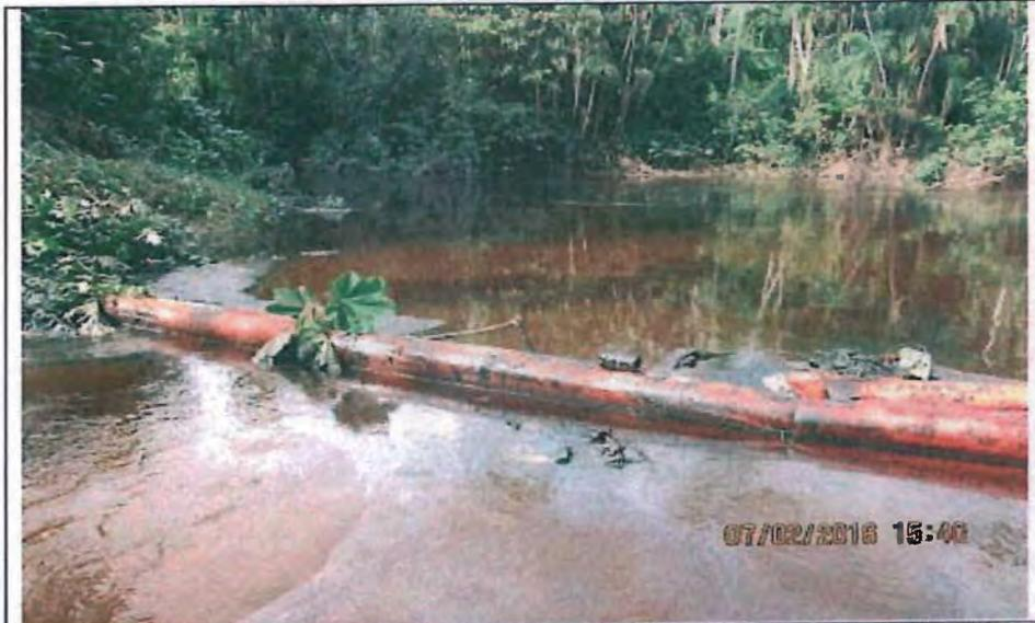
Foto 16: Muestra la primera barrera de contención ubicada a unos 500m aproximadamente aguas adentro de la Quebrada Cashacaño, se observa delante de la barrera una mínima presencia de crudo retenido, y arrastre de crudo después de la barrera de contención debido a la fuerte corriente que presenta en este punto la referida Quebrada.
