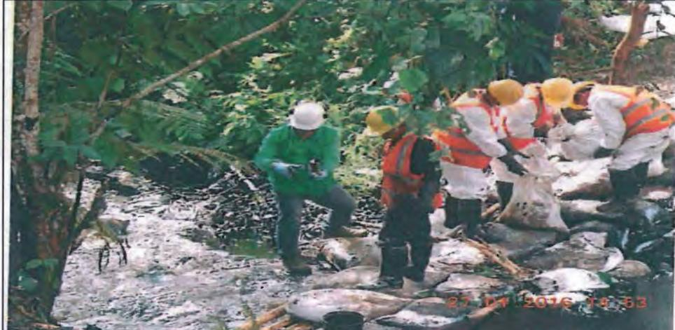
Foto 08: Muestra los trabajos que viene realizando la empresa PETROPERU instalando barreras de contención en el cauce de la quebrada Inayo, aguas abajo del punto del derrame. Además, se observa a un especialista del OEFA tomando muestras de agua superficial en la mencionada quebrada.
