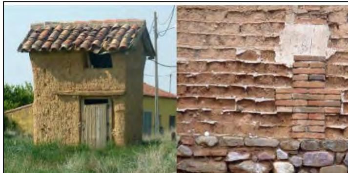
*Figura 19.* Erosión superficial de los muros de adobe.
