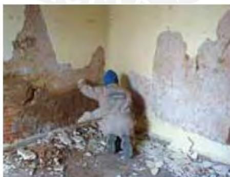
*Figura 55. Trabajos de rehabilitación de revoques y/o acabados en muros.*
