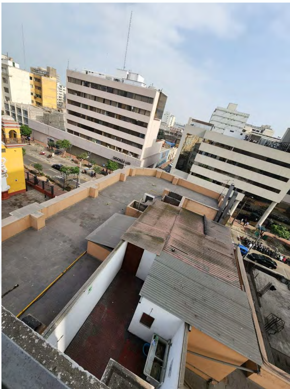
Fotografía 3: Techos de locales ubicados en Jirón Camaná y Jirón Ocoña, octubre 2022
