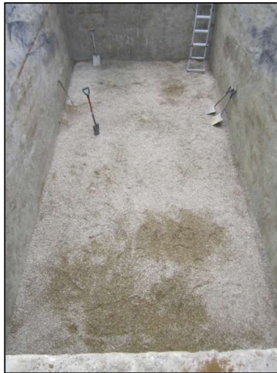
Figura 4-1: Caja de concreto con cama de tubería para la Prueba 1, (SHARMA, 2013).
