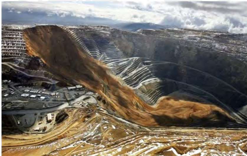
Figura 1.1: Deslizamiento Manefay ocurrido en 2013 en la Mina Bingham Canyon (Ross, 2017).
