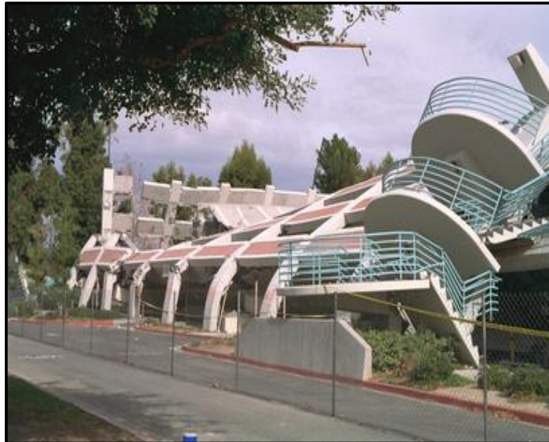
Figura 3.1. Colapso de un edificio de estacionamientos en la Universidad de California, producto del sismo de Northridge de 1994. (USGS, 1994)
