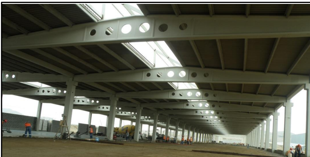
Figura 2.7. Vigas tipo delta en la construcción del almacén de Cerámicas San Lorenzo (extraído del catálogo de Preansa)
