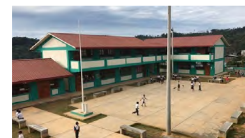
Foto: Escuela de Educación pública en zona rural, San Martín-Perú Fuente: MINEDU
