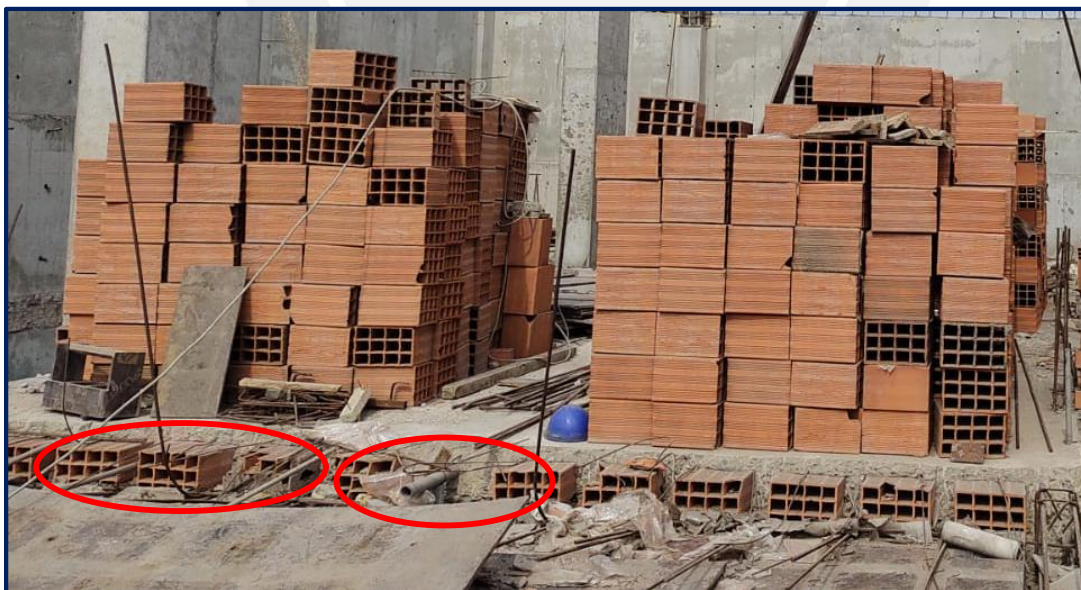
Figura 8.11: Tuberías retiradas de las instalaciones Fuente: Elaboración propia, 2022
