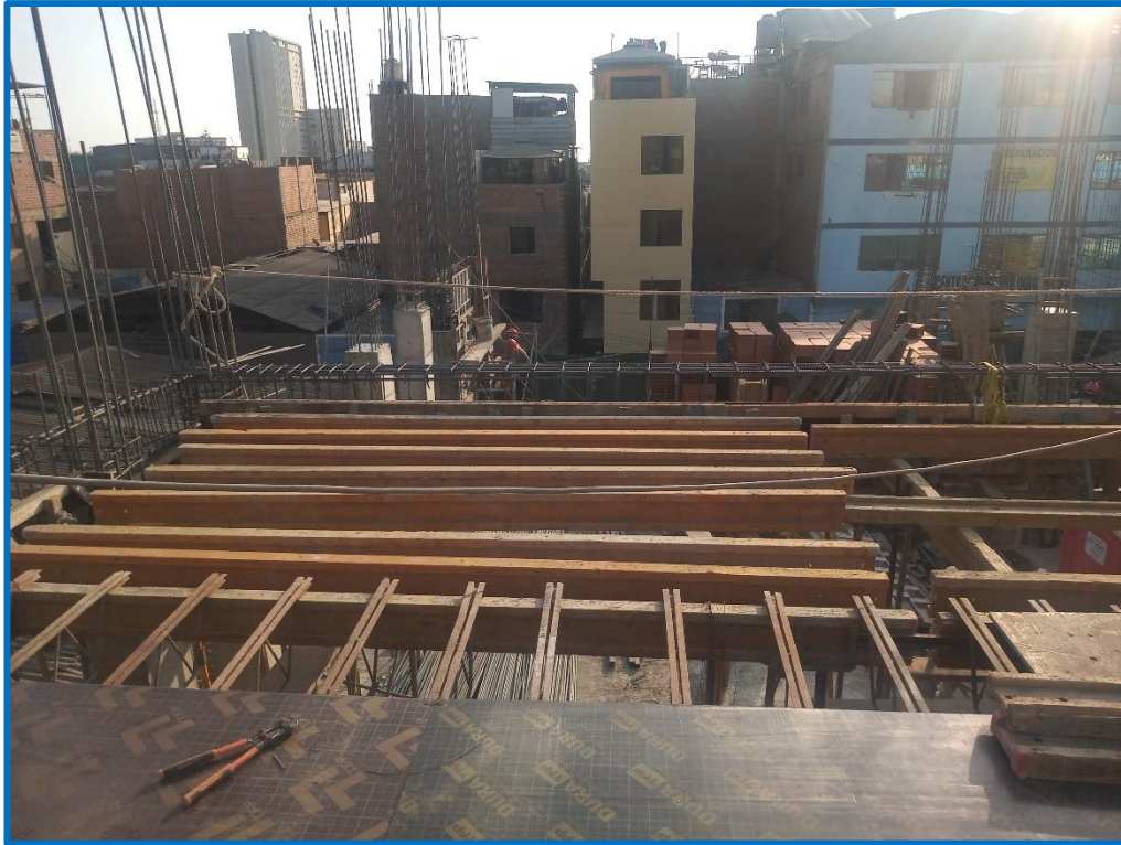
Figura 7.5: Colocación de fenolicos para fondos de losa Fuente: Elaboración propia, 2022
