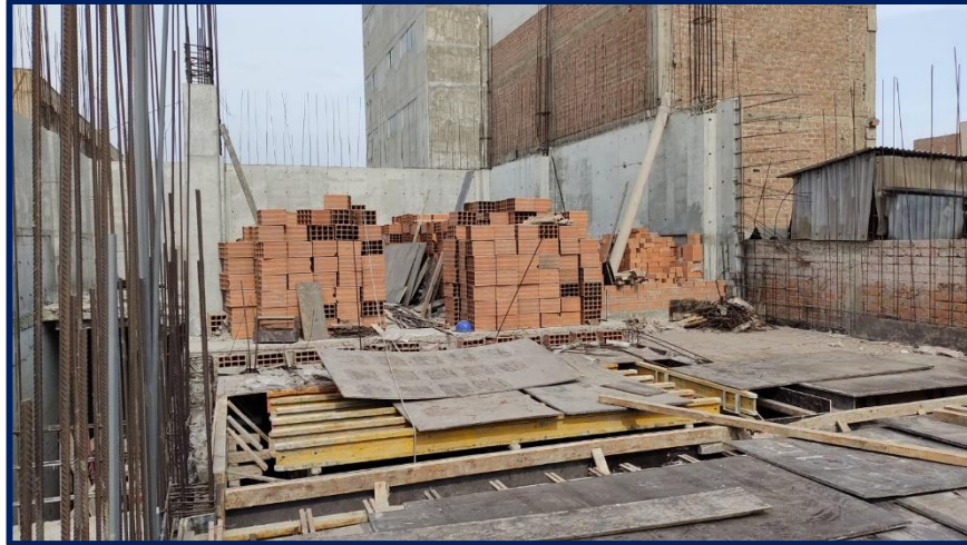
Figura 3.4: Ladrillo techo expuesto al medio ambiente Fuente: Elaboración propia, 2022
