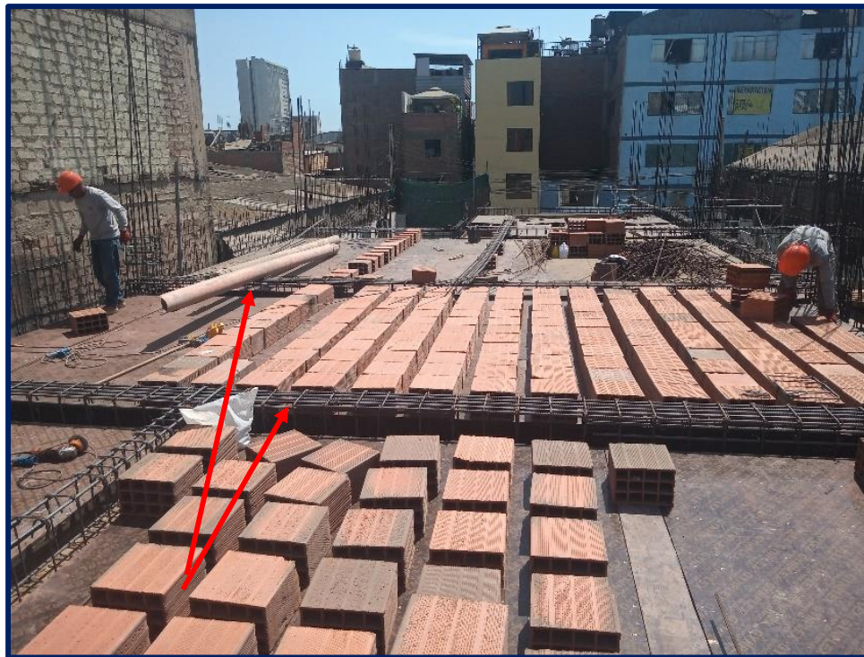
Figura 8.8: Colocación de acero nuevo en vigas Fuente: Elaboración propia, 2022
