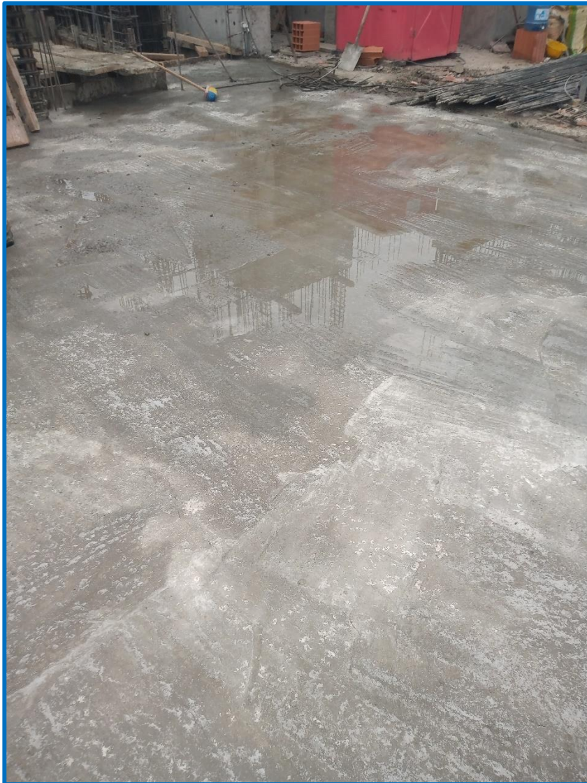
Figura 7.11: Curado de losa con agua 03 veces al día, por una semana. Fuente: Elaboración propia, 2022
