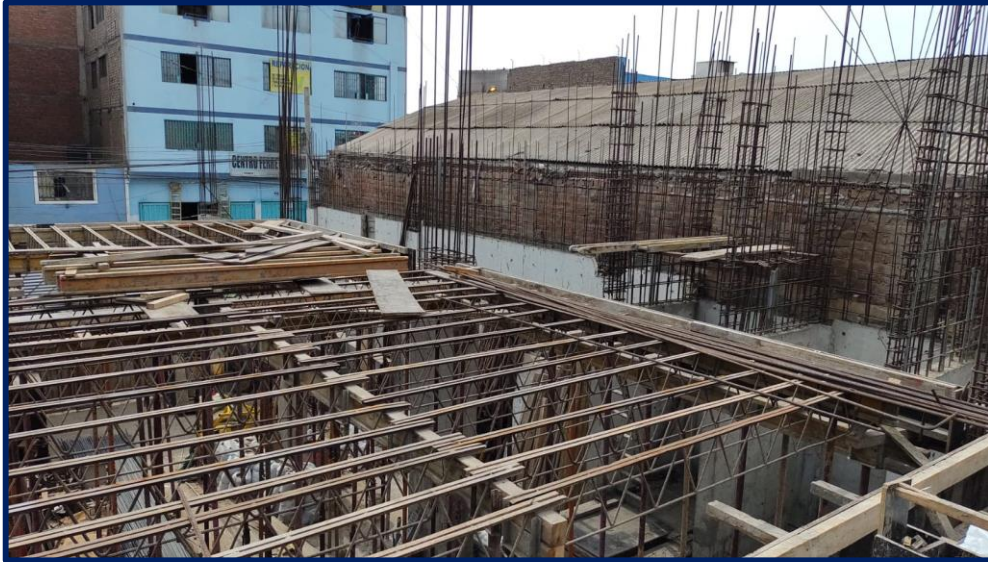
Figura 3.10: Retiro del 100% de encofrado colocado Fuente: Elaboración propia, 2022
