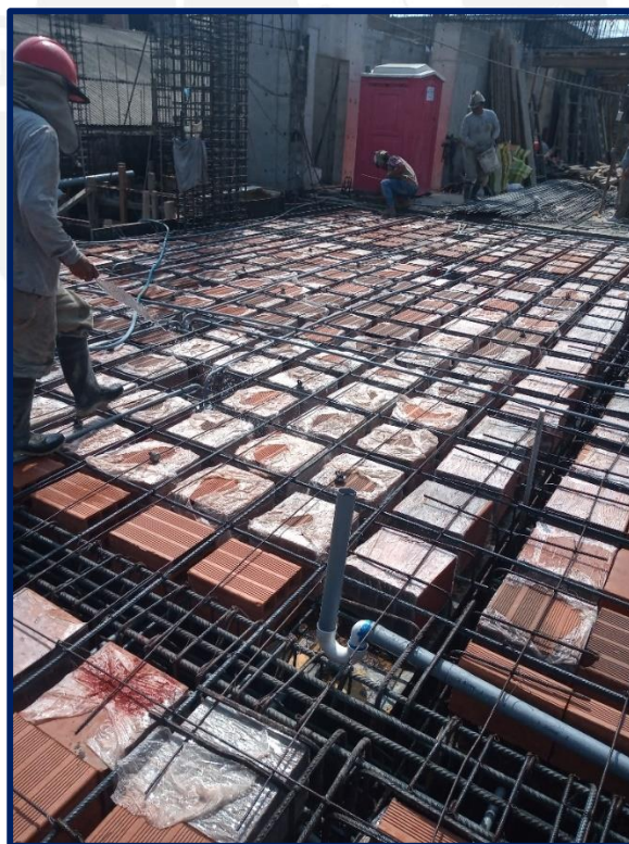
Figura 7.1: Puesta de ladrillo para losa en dos direcciones Fuente: Elaboración propia, 2022
