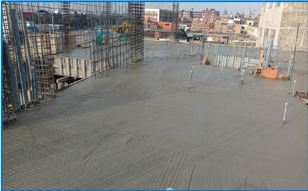
Figura 7.10: Vaciado de losa con concreto de resistencia f'c=280\text{kg/cm}^2 Fuente: Elaboración propia, 2022
