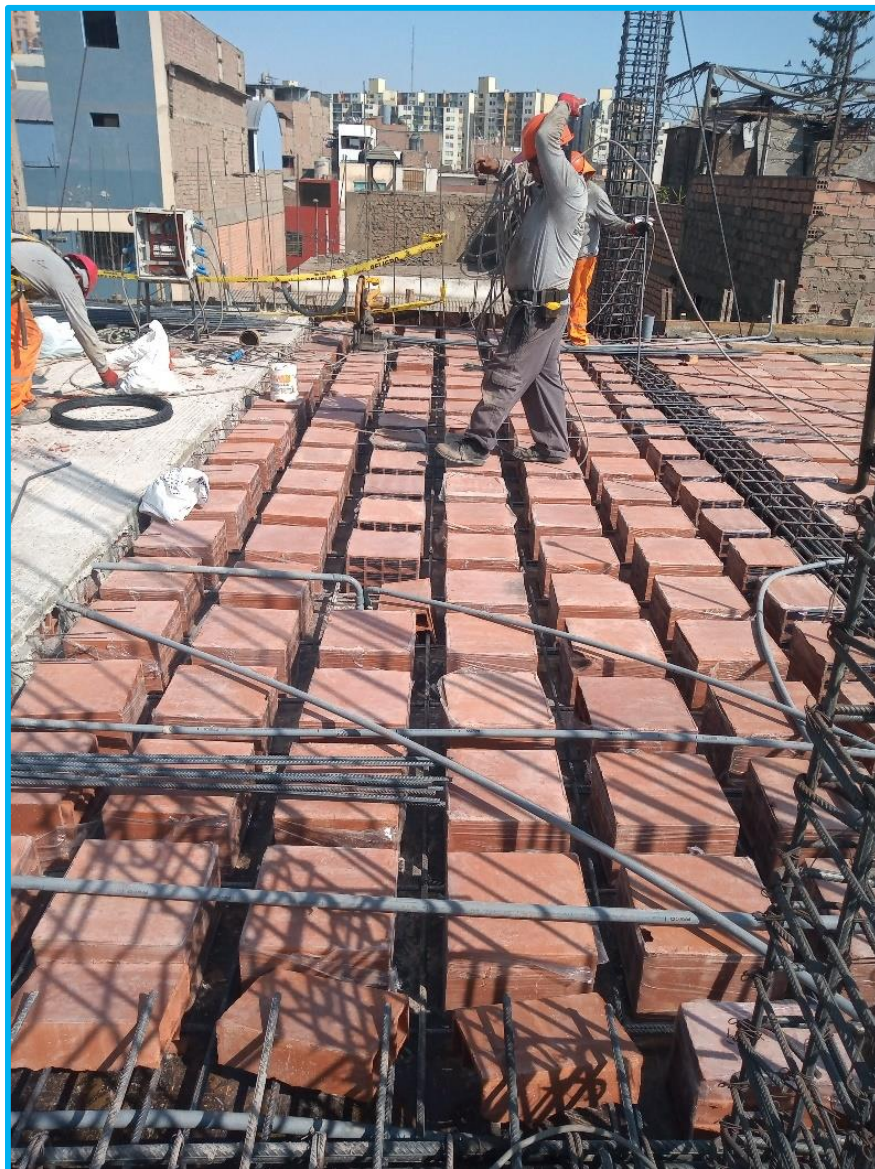
Figura 7.8: Puesta de tuberías para IISS e IIEE Fuente: Elaboración propia, 2022
