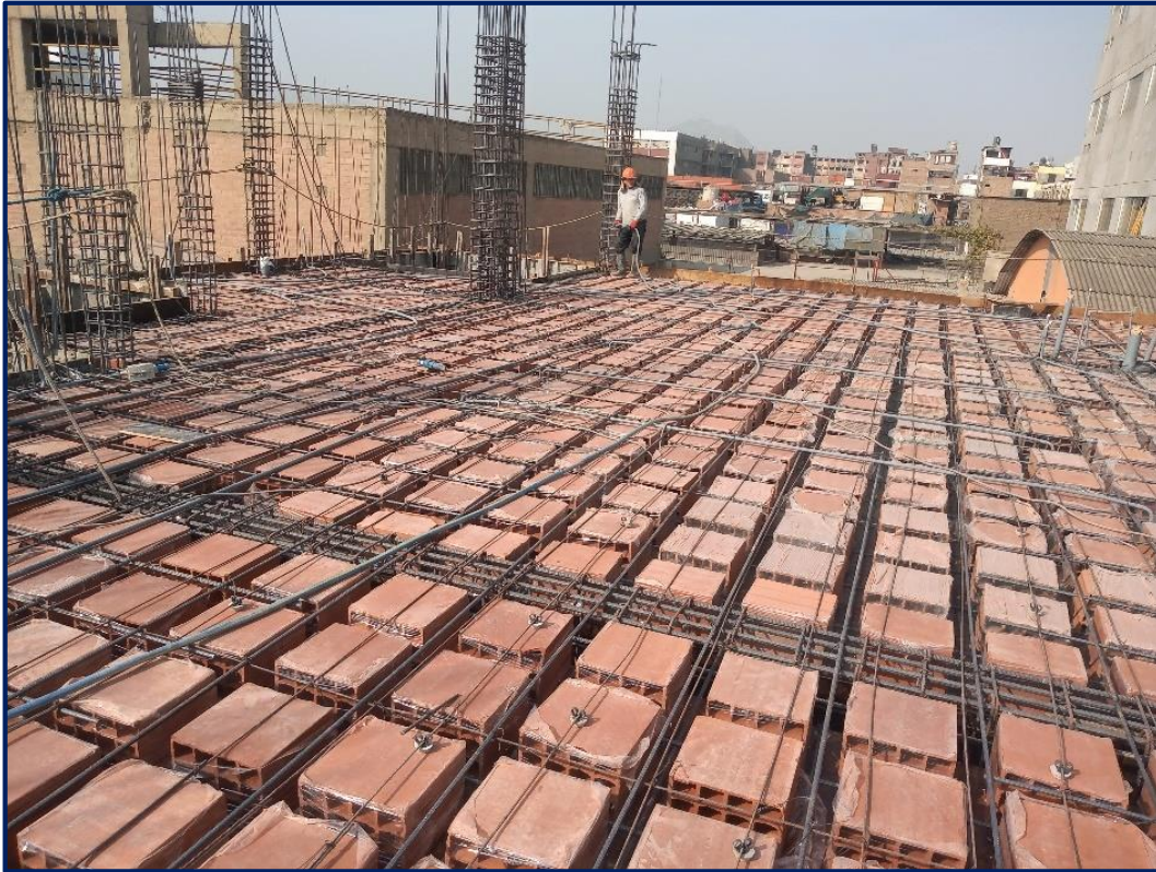
Figura 7.9: Losa en dos direcciones con protocolo de liberación Fuente: Elaboración propia, 2022
