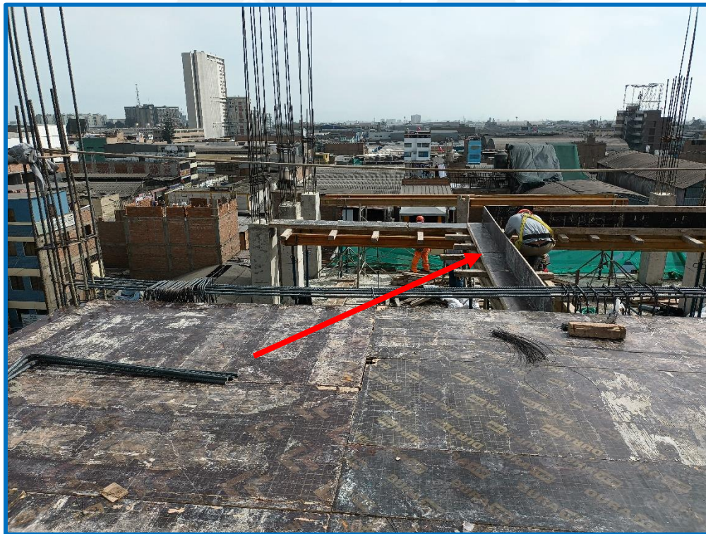
Figura 7.4: Ejecucion de fondos y costados de viga Fuente: Elaboración propia, 2022
