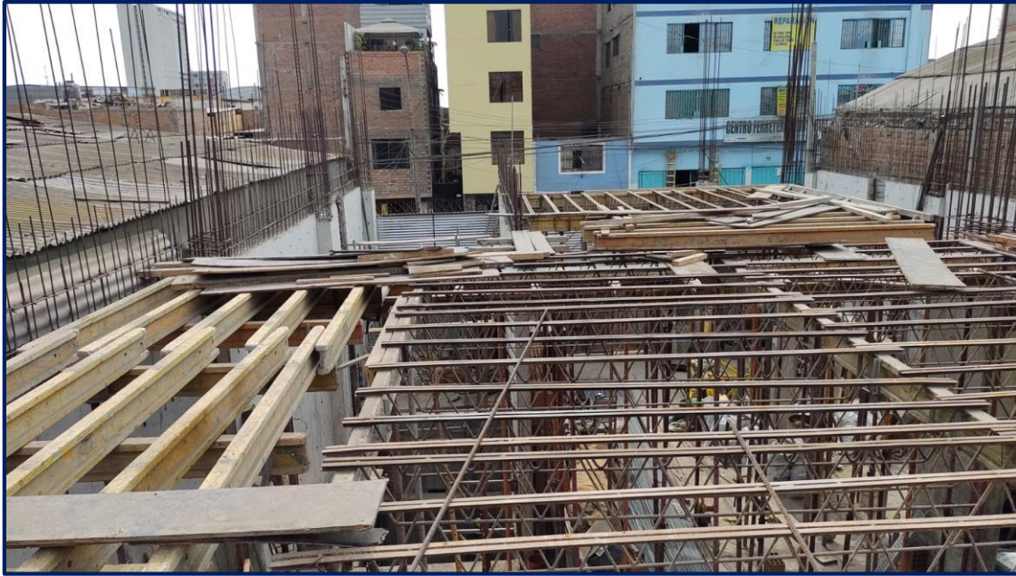
Figura 8.6: Retiro de material fenólico Fuente: Elaboración propia, 2022
