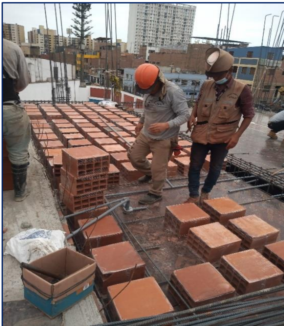
Figura 7.7: Puesta de material fenólico para fondos de losa Fuente: Elaboración propia, 2022
