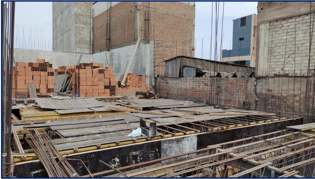
Figura 3.6: Material fenólico con daños de resistencia por exposición al medio ambiente Fuente: Elaboración propia, 2022
