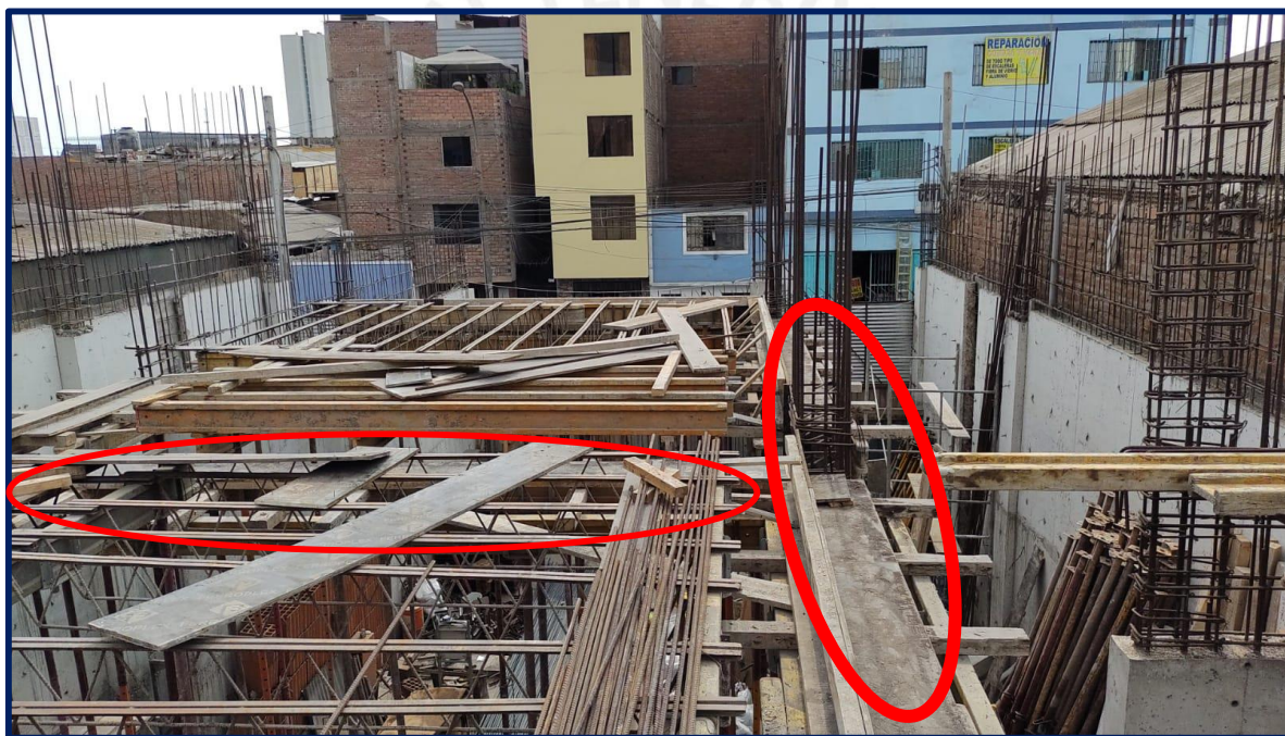
Figura 8.4: Retiro de acero oxidado en todas las vigas Fuente: Elaboración propia, 2022
