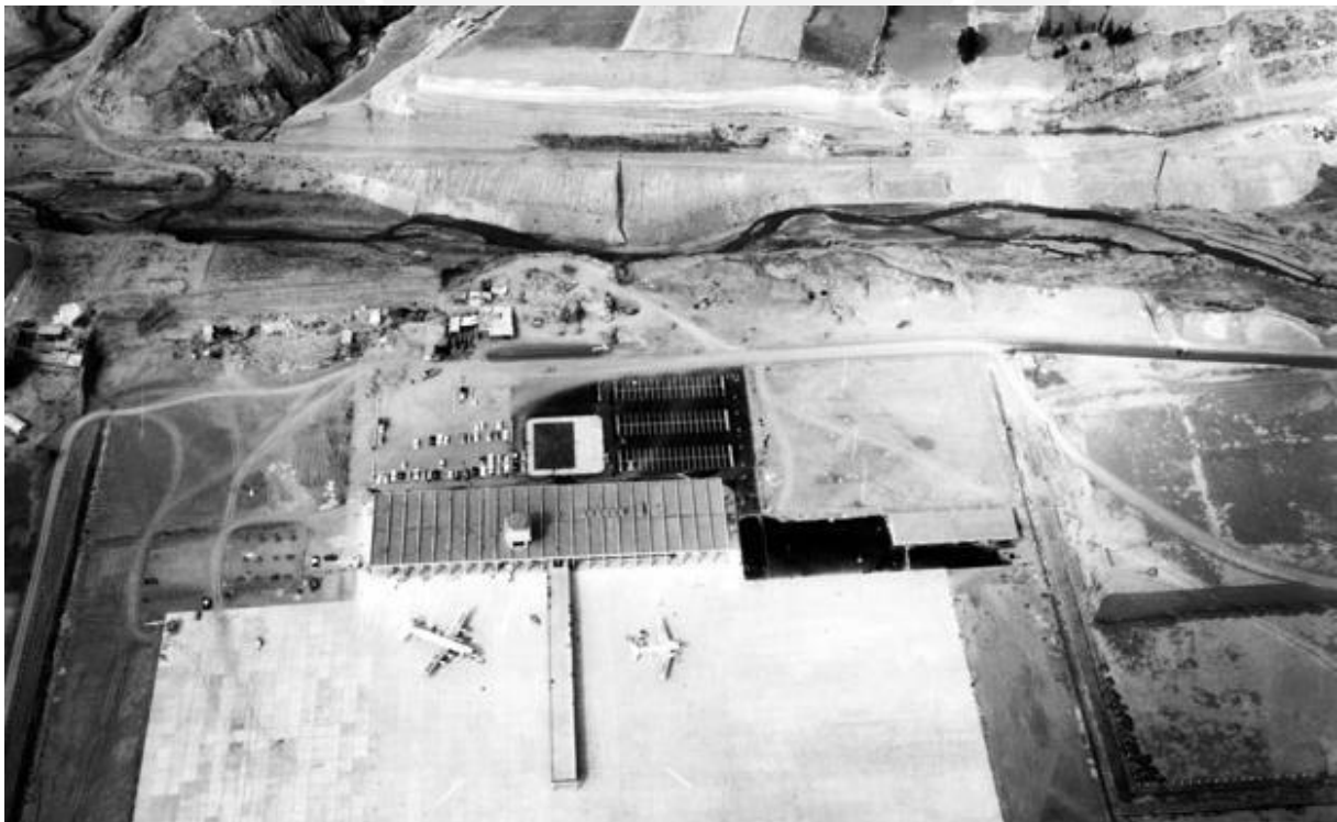
Imagen-2. Vista aérea del aeropuerto. Fuente: Catalogo arquitectura movimiento moderno Perú. 2015. Archivo de Antenor Orrego.
