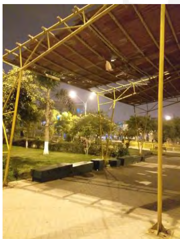
Figura 30 Mobiliario de cubierta de sombra. Fotografía propia
