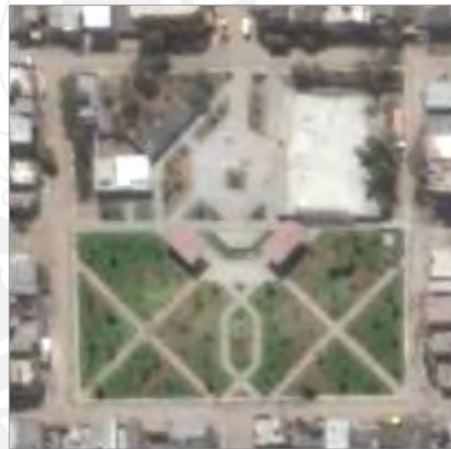
Ejecución del Parque José Olaya - 2008 Presupuesto Participativo de la Municipalidad
