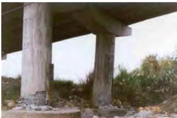
Figura 2.6: Daño concentrado en la base de un puente
