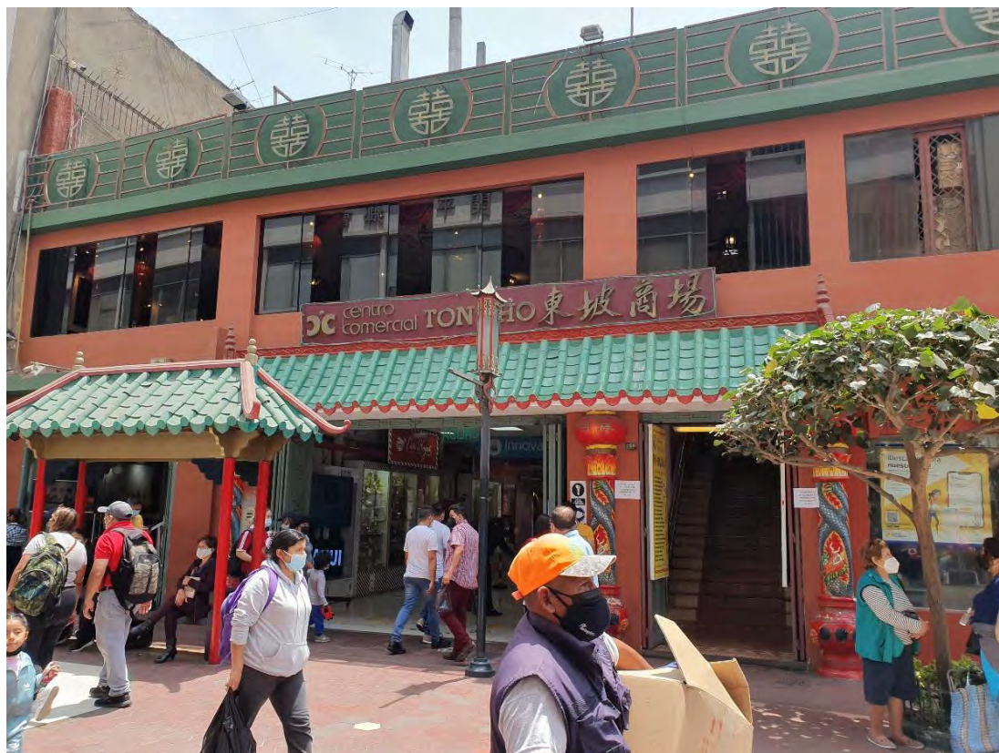
Figura 15. Fotografía exterior del centro comercial “Ton-Pho”. Año: 2021. Fuente: propia.
