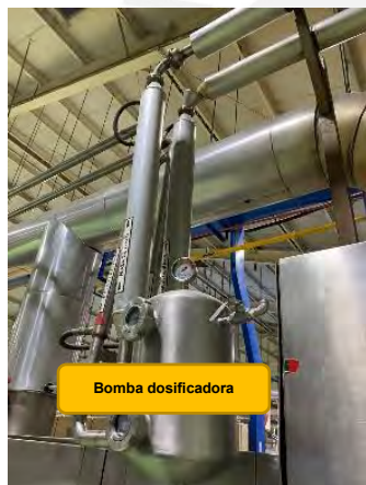
Figura 16 Bomba dosificadora
