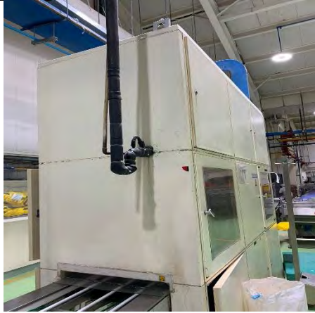
Figura 21 Cámara de frío
