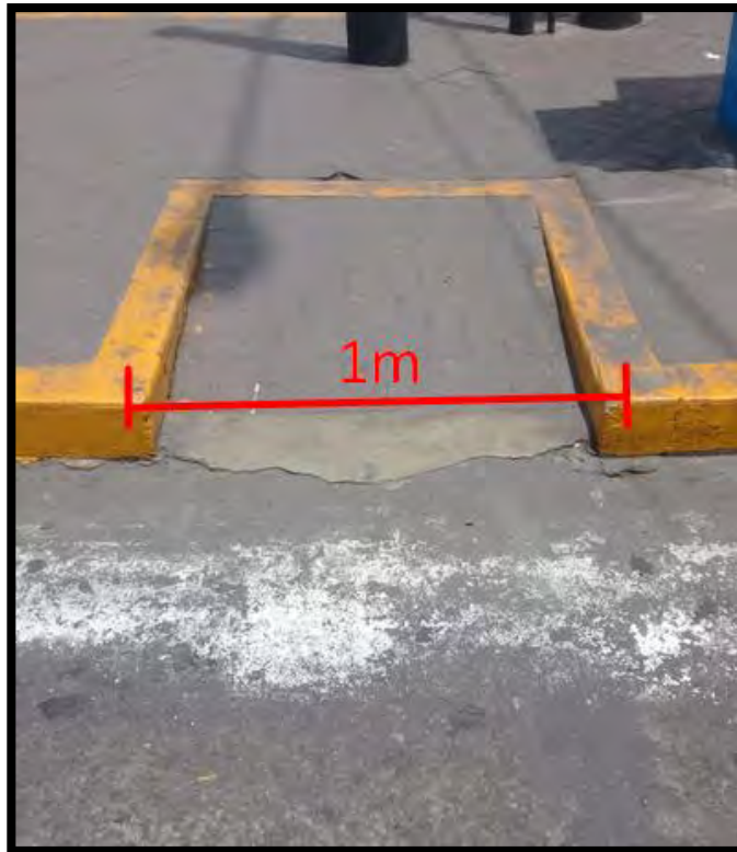
Figura 45: Rampas en la intersección Fuente: Elaboración propia
