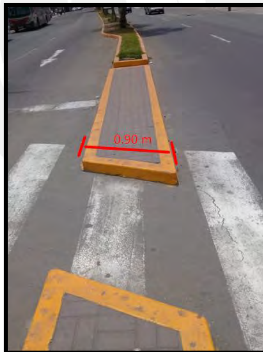
Figura 40: Isla con ancho inadecuado Fuente: Elaboración propia
