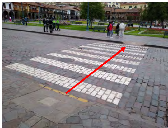
Figura 32. Fotografía de rampas R9 y R10. Fuente: Propia.
