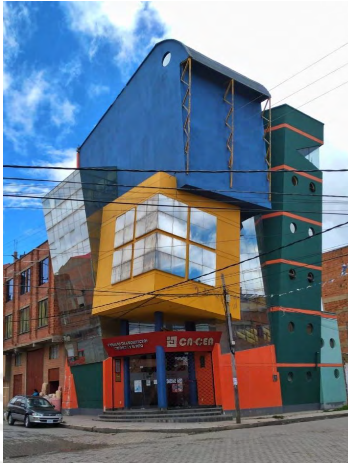
Figura 2. Colegio de Arquitectos de la ciudad de El Alto. Fotografía de la autora
