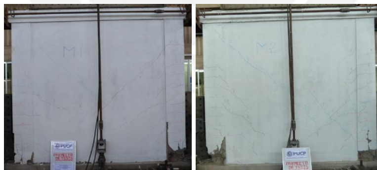
Figura 2.13: Estado último de los muros sometidos a carga cíclica lateral y carga constante de 110 kN (izquierda) y 160 kN (derecha) (Quiun & Mamani, 2017).
