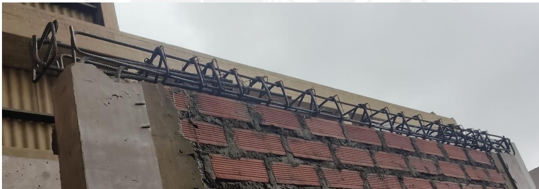
Figura 7.15: Armado de la viga solera.
