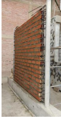
Figura 7.11: Muro de albañilería tubular terminado.
