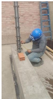
Figura 7.7: Uso de escantillón para el asentado de ladrillos.
