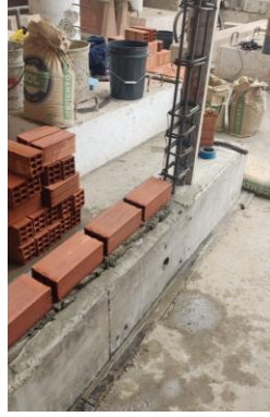
Figura 7.8: Asentado de ladrillos.
