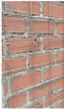
Figura 7.18: Conexión de malla electrosoldada en el muro.
