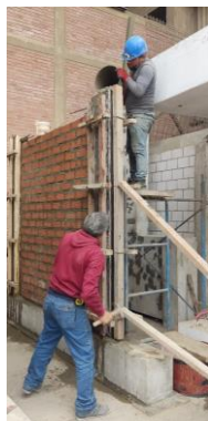
Figura 7.13: Vaciado de concreto de columnas.
