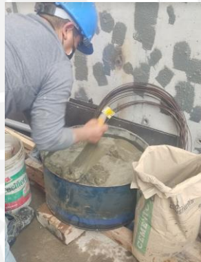
Figura 7.9: Mortero empleado en las juntas verticales y horizontales.
