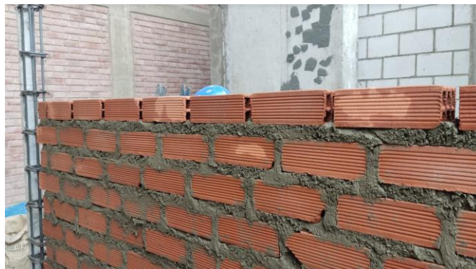
Figura 7.10: Asentado de ladrillos.
