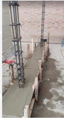
Figura 7.6: Vaciado de concreto de viga de cimentación.
