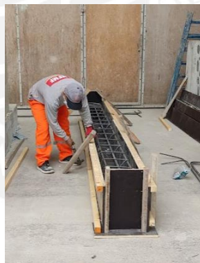
Figura 7.4: Habilitación de acero de viga de cimentación.
