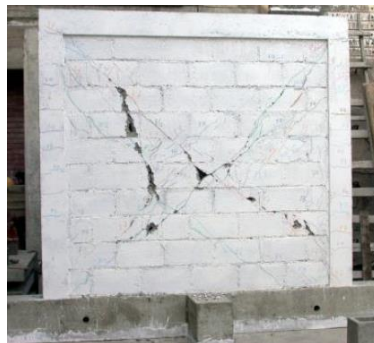
Figura 2.4: Muro M1 sin refuerzo ensayado (Quiun et al., 2005).
