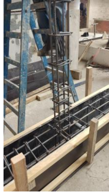
Figura 7.5: Colocación de tubo de PVC y habilitación de columna.
