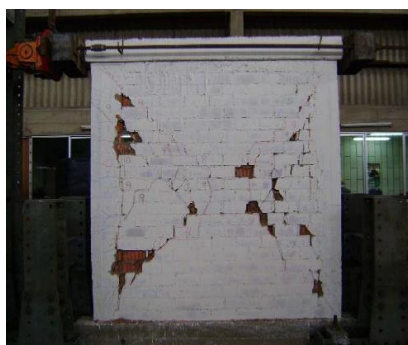
Figura 2.6: Estado final del muro M1 después de la fase armónica (Barr & Pineda, 2011).
