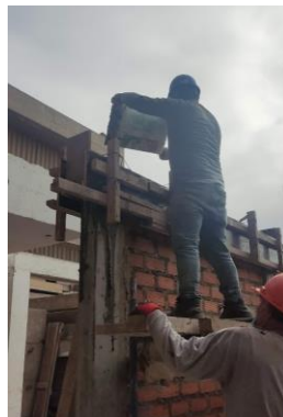
Figura 7.16: Vaciado de concreto en viga.
