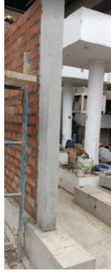
Figura 7.14: Columna desencofrada.
