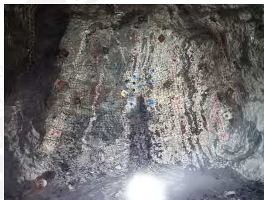
Gráfica 43: Malla de perforación con Burden 25 cm
