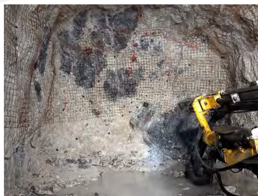
Gráfica 45: Malla de perforación con Burden 35 cm
