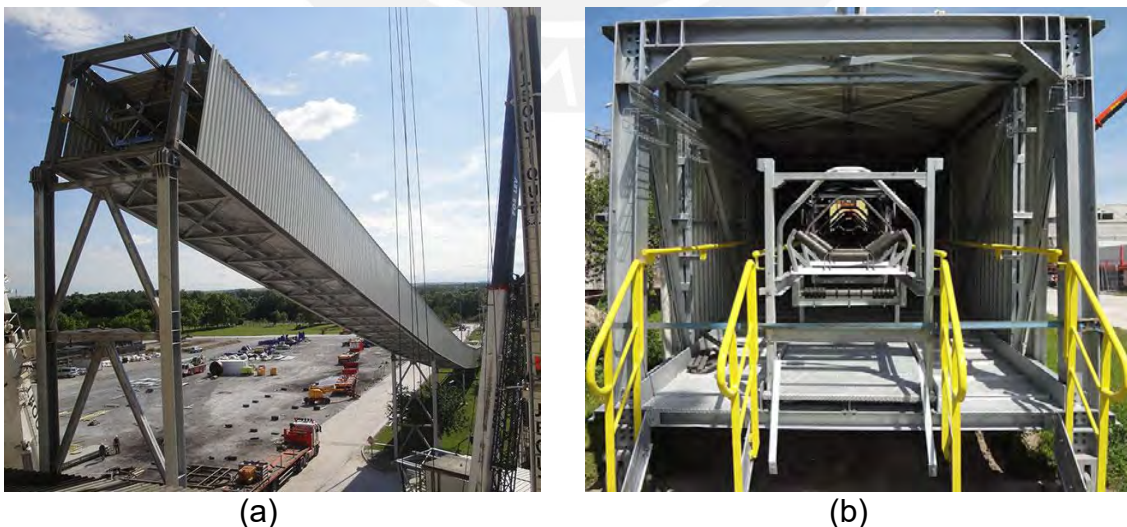
Figura I.1 (a) Galería estructural recubierta y montada con más de dos apoyos. (b) Interior de galería estructural con faja transportadora. [1]
