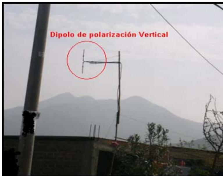
Figura 4.21 Sistema irradiante de la estación detectada en el monitoreo del caso 1
