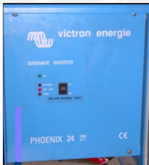
Figura 4.4 Módulo inversor de voltaje
