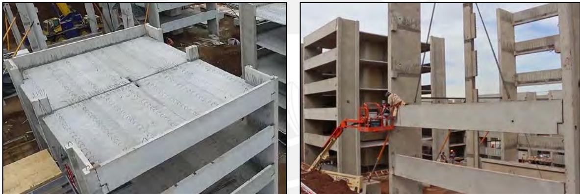
Figura 2.50 (a) Sistema de piso de concreto prefabricado y (b) Izaje y montaje de viga invertida (Momenta, 2016)
