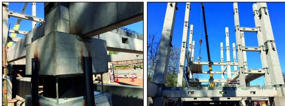
*Figura 2.52 Estructura de concreto prefabricado con sistema de aisladores sísmicos (Chapple, 2020)*
