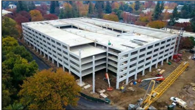
*Figura 2.51 Izaje y colocación de los elementos prefabricados del estacionamiento 5 de CSU Sacramento (Clark Pacific, s.f.)*
