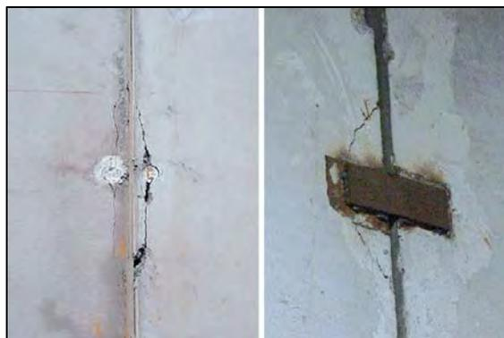
Figura 2.38 Agrietamiento en la conexión entre muros (Henry & Ingham, 2011)
