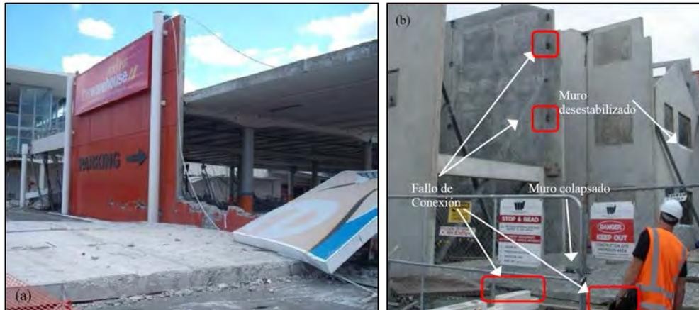
Figura 2.39 Colapso de muros estructurales *tilt-up* de hormigón prefabricado: (a) Falla de flexión localizada a lo largo de la base del panel de muro; (b) Desestabilización de muro de concreto *tilt-up* en construcción. Adaptado de Kam, Pampanin, & Elwood (2011).
