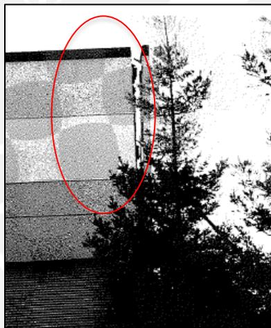
Figura 2.36 Ejemplo de la separación entre el muro *tilt-up* y el diafragma del techo (Mitchell et al, 1995)
