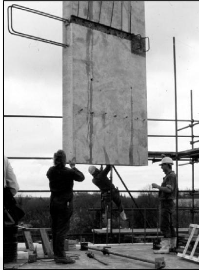
*Figura 2.44 Ejemplo de conexión muro-muro y con detalle para sus conexiones con vigas y diafragma (Task Group 7.3, 2003)*
