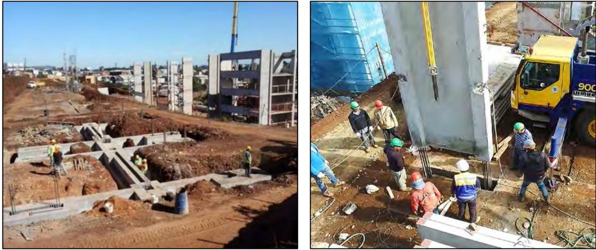
Figura 2.49 (a) Cimentación tipo cajón con grout (Jaspard, 2017) y (b) Colocación del muro prefabricado sobre su cimentación (Momenta, 2016)
