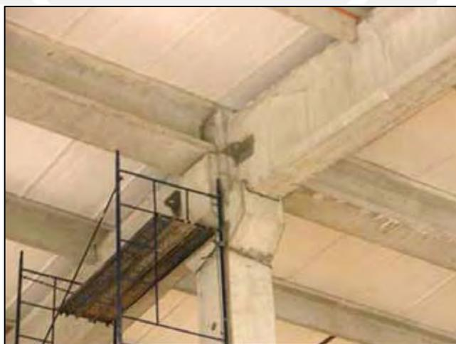
*Figura 2.23 Junta húmeda entre vigas y columnas en un edificio industrial que funcionó bien durante el terremoto (Ghosh & Clealand, 2012)*
