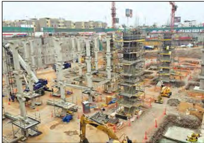
*Figura 1.1 Sótano con columnas prefabricadas en el Centro de Convenciones de Lima (Construcción y Vivienda, 2015)*
