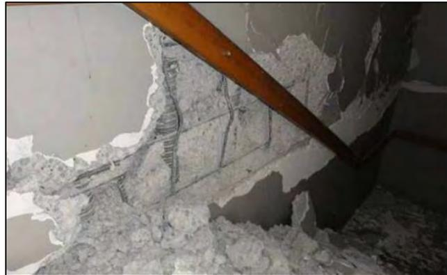
Figura 2.46 Falla de los ductos con lechada (Kam, Pampanin, & Elwood, 2011)
