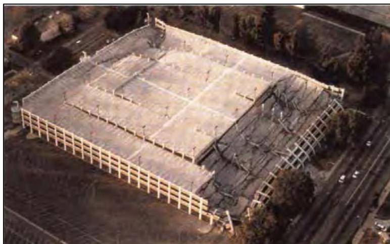
Figura 2.6 Garaje parcialmente colapsado en CSUN (Iverson y Hawkins, 1994)
