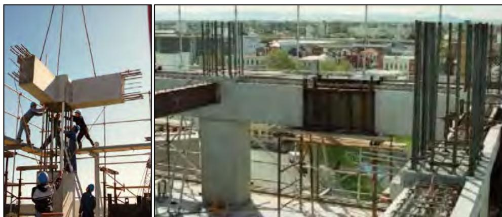
Figura 2.24 (a) Colocación del nudo prefabricado y (b) Conexión viga-viga
