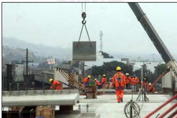
*Figura 1.2 Montaje de vigas prefabricadas para el Viaducto del Tren Eléctrico (Andina, 2013)*
