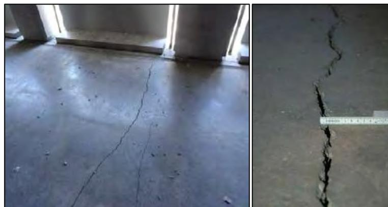
*Figura 2.26 Grietas en el firme del diafragma prefabricado de la Torre Brannigan a causa del terremoto de Christchurch (Fleischman et al. 2014)*
