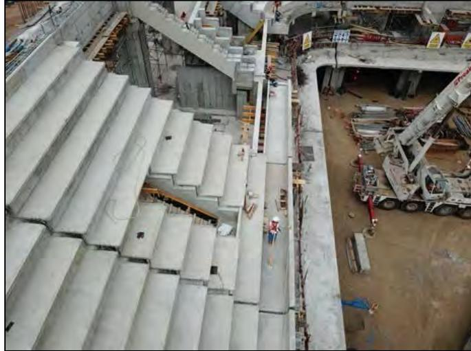
Figura 1.3 Instalación de graderías prefabricadas (Preansa, 2019)
