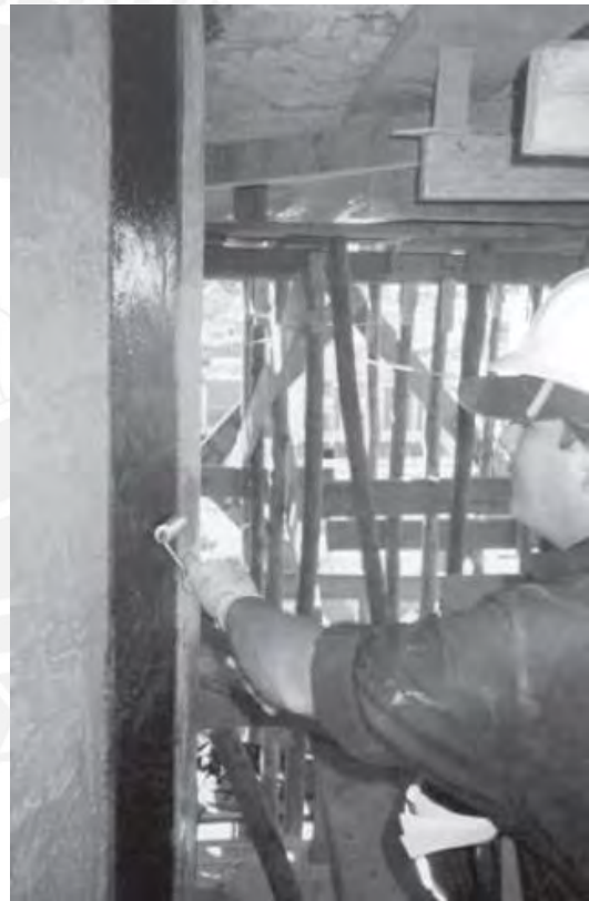
Figura 2.20. Refuerzo con mantas de CFRP de la torre afectada (Tumialan et al., 2003)
