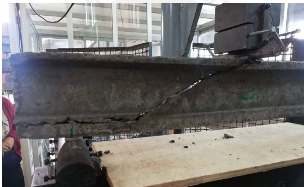
Figura 6.8. Detalle de la grieta de falla por tracción diagonal en el apoyo
