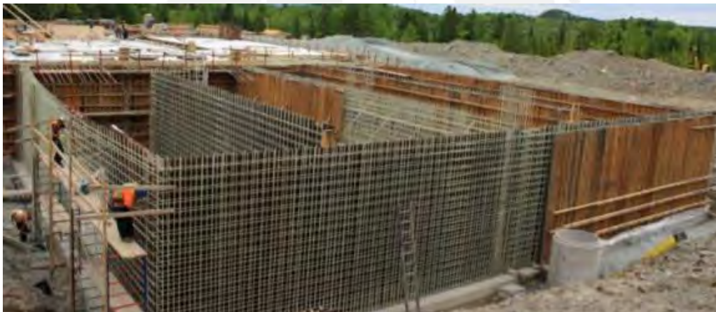
Figura 2.13. Planta de tratamiento de agua reforzada con barras de GFRP en Canadá (Mohamed y Benmokrane, 2013)
