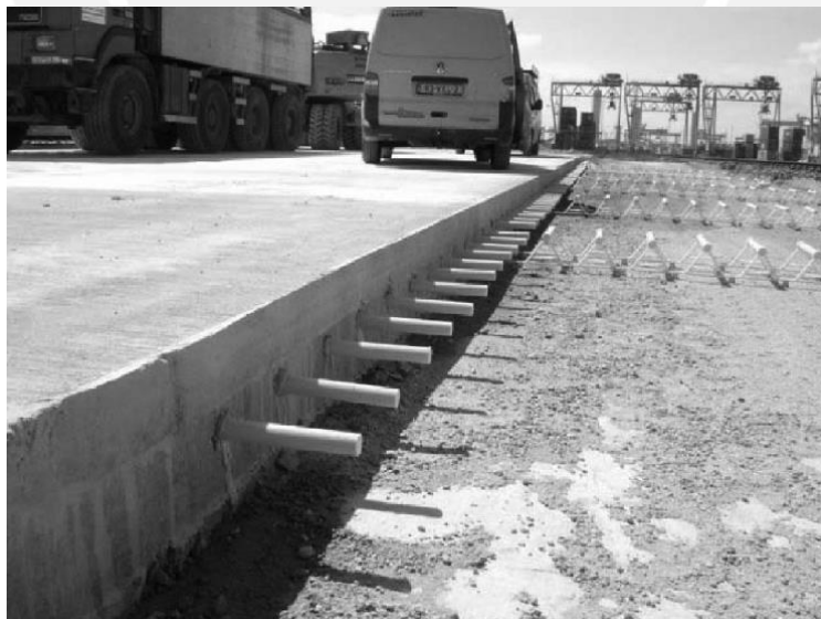
Figura 2.15. Pasadores de GFRP en pavimento de Rotterdam, Países Bajos (ACI, 2007)
