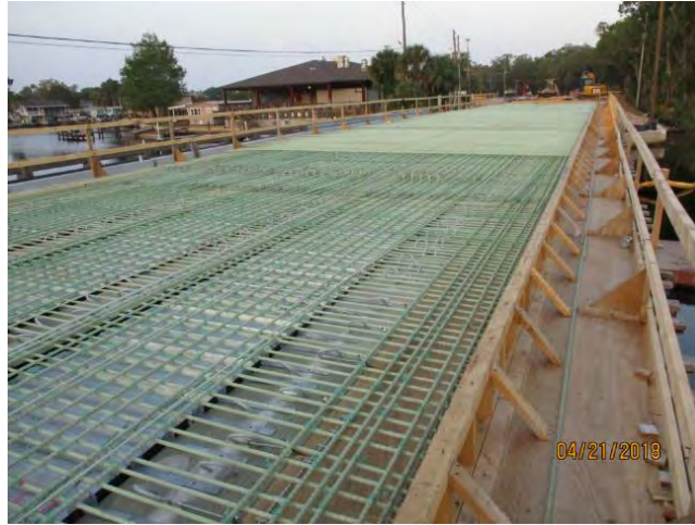
Figura 2.10. Armado de barras de GFRP en losa de puente (Nanni, 2019)
