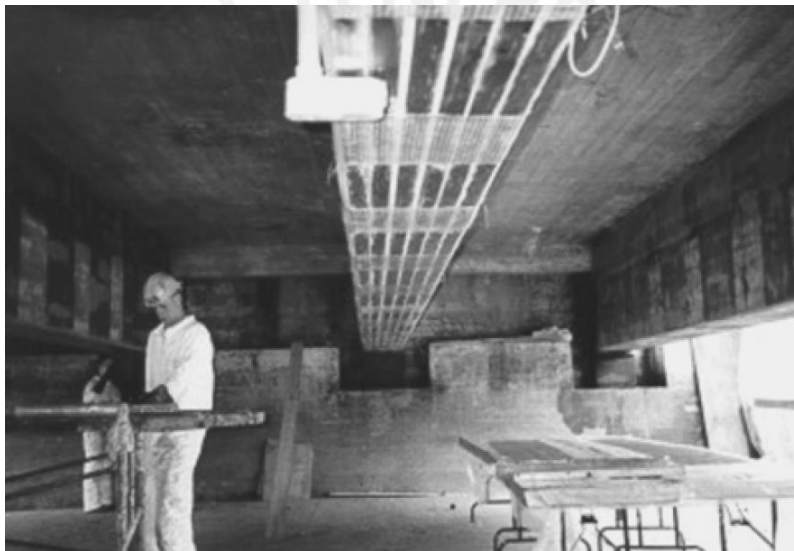
Figura 2.16. Aplicación de tiras de CFRP para refuerzo de flexión (ACI, 2007)
