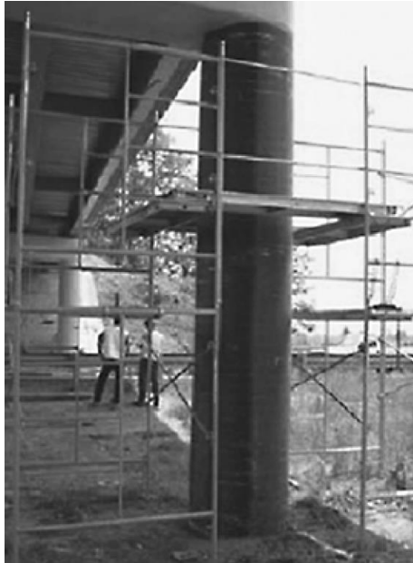
Figura 2.17. Envolvimiento en manta de CFRP de columna de puente Creek, Canadá (Balaguru et al., 2009)
