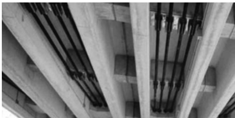
Figura 2.18. Tendones de presfuerzo externos en el puente Bridge Street, USA (ACI, 2007)
