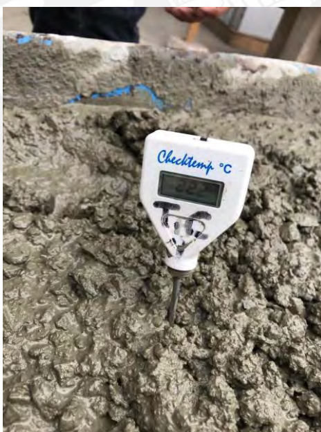
Figura 5.3 Control de temperatura de la mezcla de concreto
