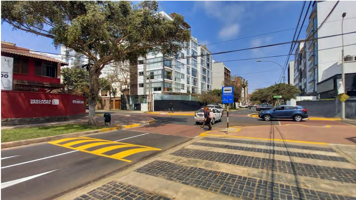
Figura 23. Fotografía representativa de vía de tránsito de peatones 1
