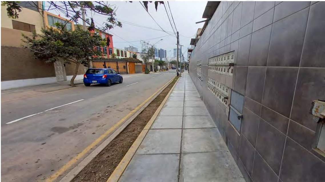
Figura 24. Fotografía representativa de vía de tránsito de peatones 2
