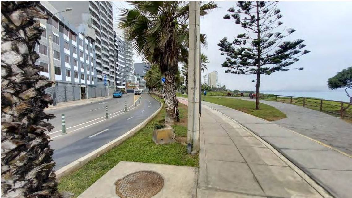
Figura 28. Fotografía representativa de vía de tránsito de peatones 6
