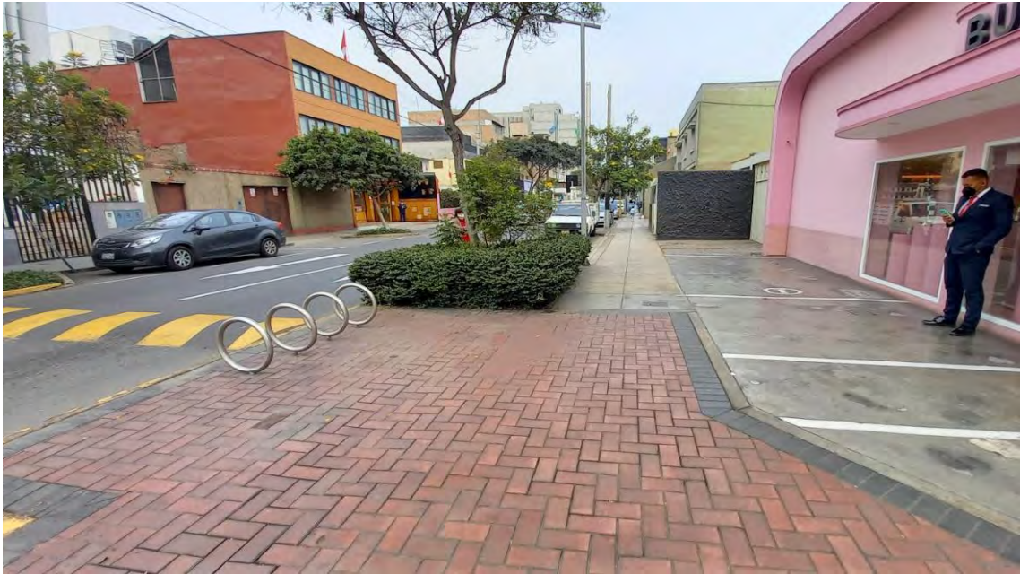
Figura 27. Fotografía representativa de vía de tránsito de peatones 5
