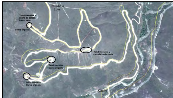
Figura 3. Giros angostos con taludes inestables. Fuente: Google Earth
