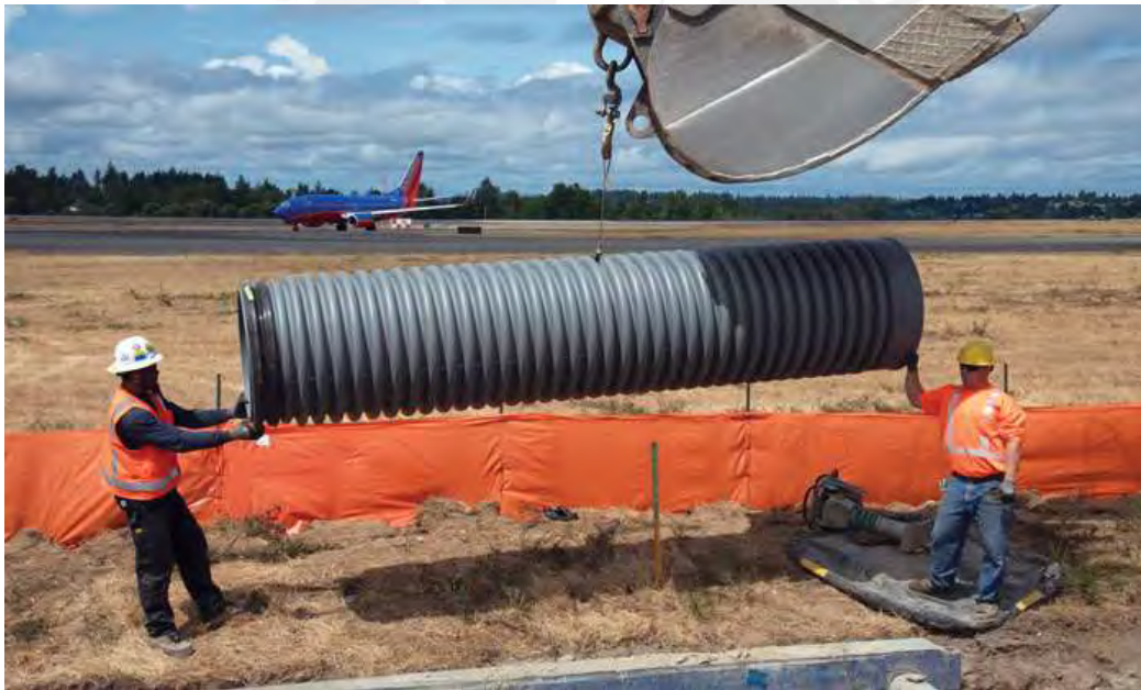
Figura 16. Instalación de tubería de polipropileno en aeropuerto.
