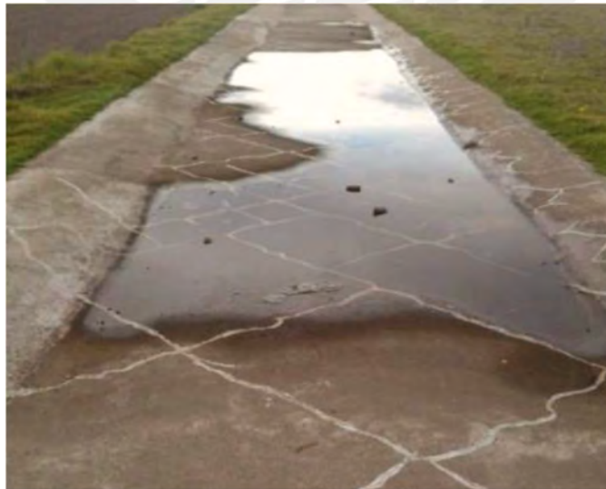
Figura 30. Estado actual de los canales perimetrales.
