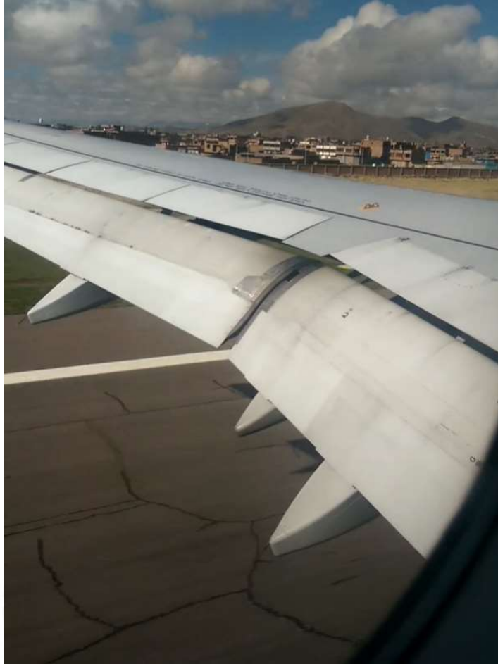
Figura 29. Presencia de fisuras lineales y en malla en la pista de aterrizaje del aeropuerto.
