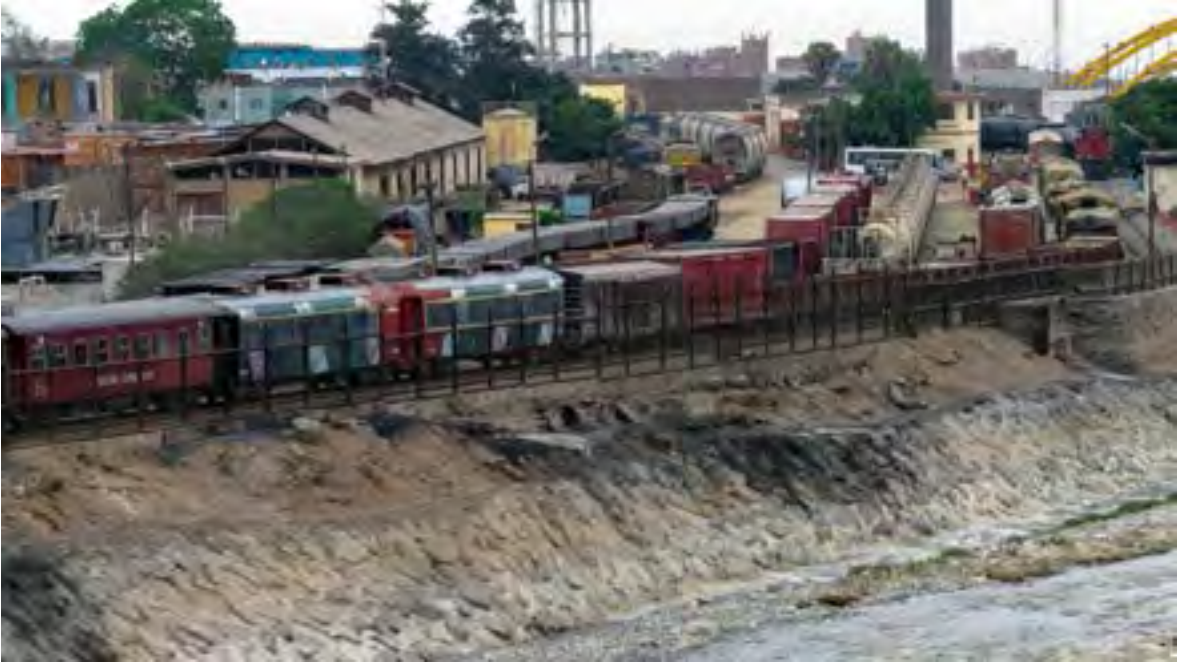
Figura 4. Vista desde la Vía Expresa Línea Amarilla. Límite norte de la estación con el río Rímac, maquinaria en funcionamiento y galpón este. Fuente: FCraifan – Ferrocarril Central del Perú, 2018.
