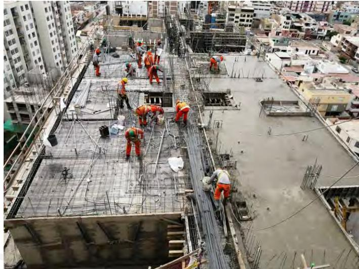
**Figura 28. Armado de losa del Sector 2 de la Torre B Uptown II, sin contar con acceso. Fuente: Propia.**
