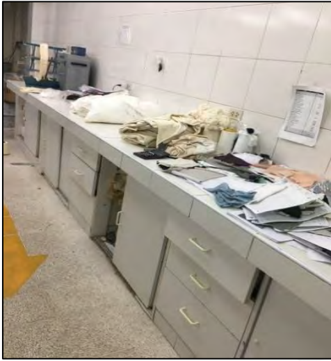
Figura 56: Falta de limpieza 1-Laboratorio
