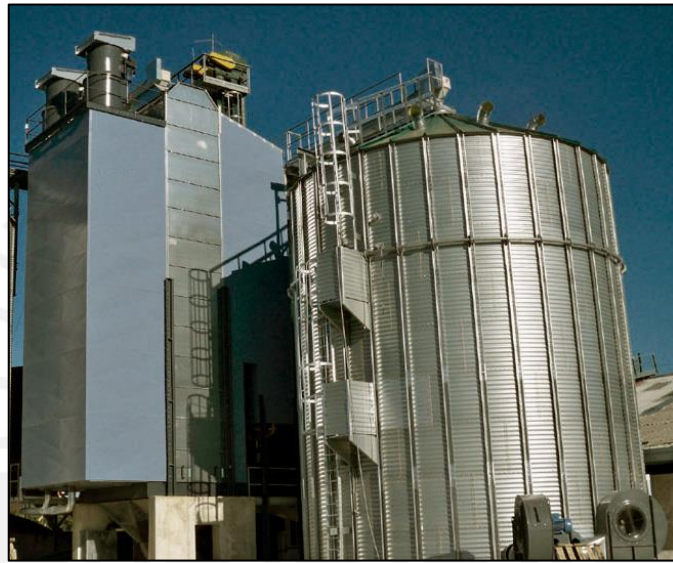
Figura 16. Silos de acondicionamiento de trigos
