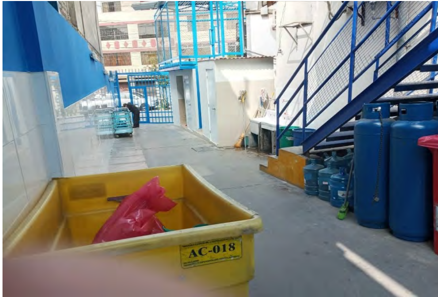
Foto N° 5: Vista actual post remodelación de la emergencia, vista posterior
