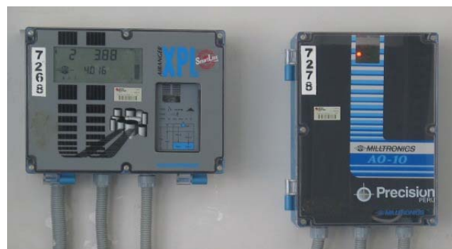
Figura 3.12 Transmisor de Nivel
