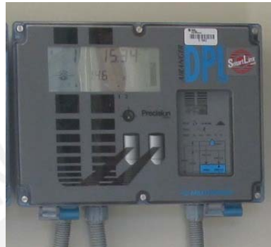
Figura 3.6 Transmisor de Nivel
