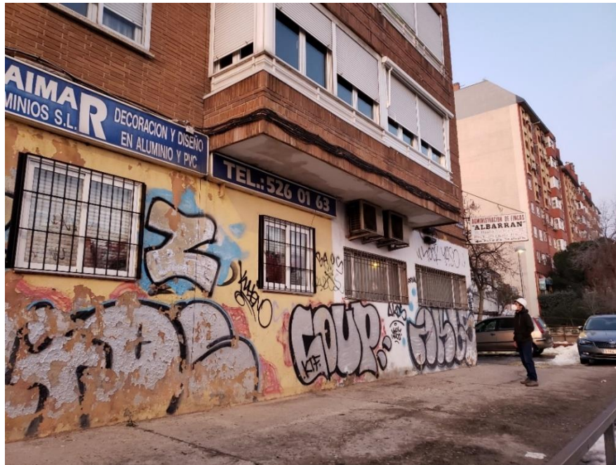
Figura 71. Imagen de la visita a la edificación seleccionada
