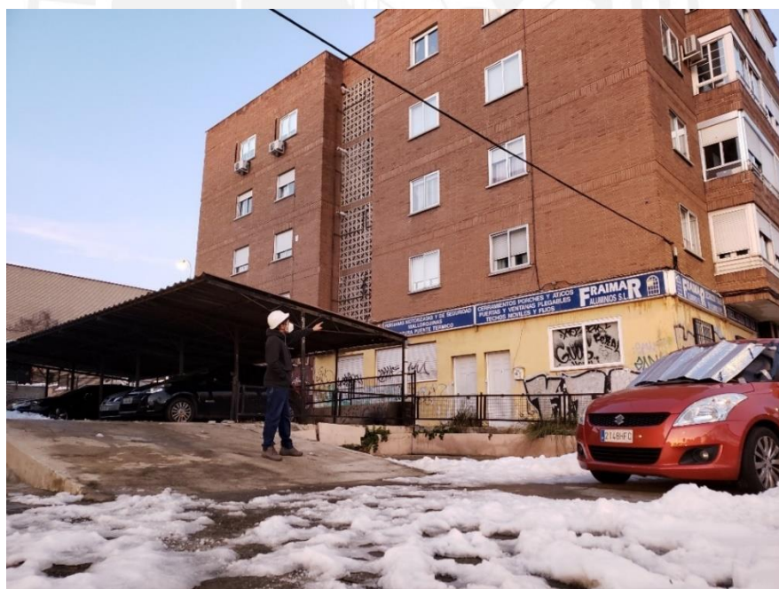
Figura 72. Imagen de la visita a la edificación seleccionada
