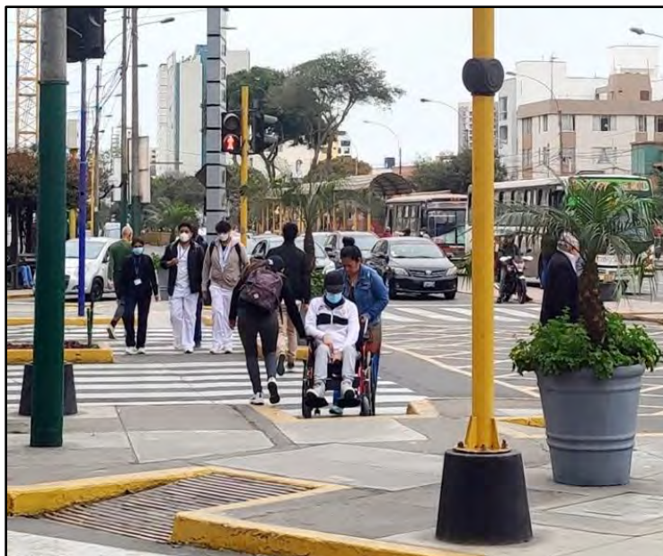
Figura 40. Pendiente excesiva en las rampas (Fuente Propia)
