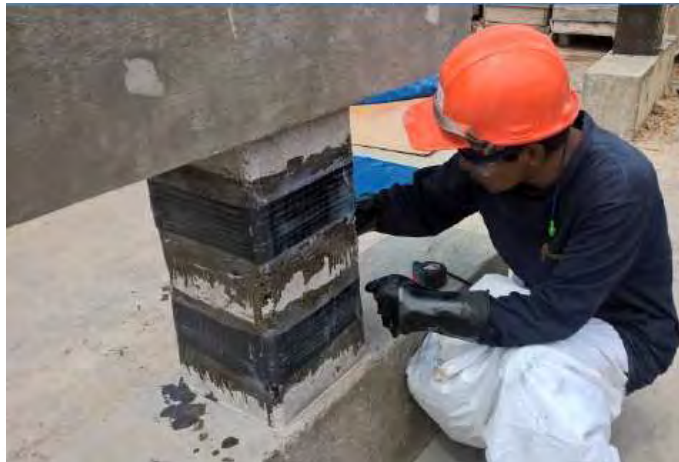
Figura 2.25: Columna reforzada con bandas de CFRP (Cornejo, 2019)
