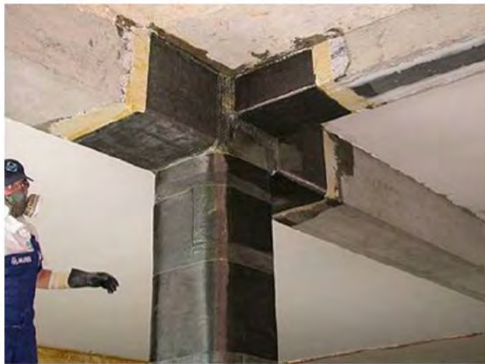
Figura 2.18: Columna reforzada con CFRP (SIKA, 2018)
