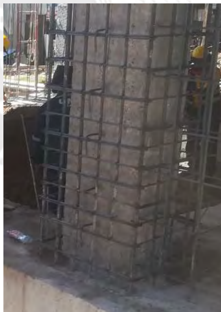
Figura 2.12: Encamisado de concreto armado
