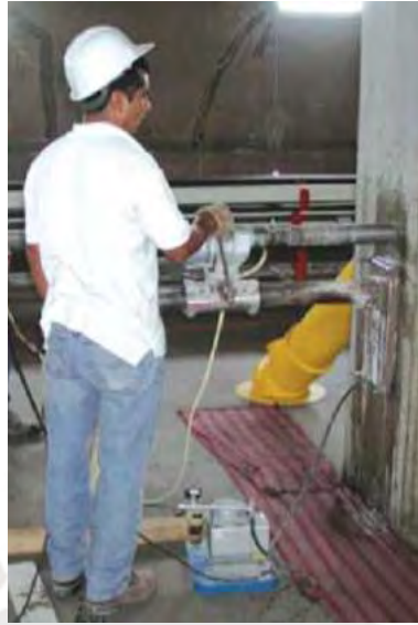
Figura 2.10: Extracción de núcleos de concreto de una columna (Damazo, 2006)
