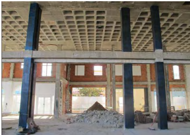
Figura 2.24: Columnas de un almacén reforzadas con CFRP (Masterbreace, 2020)
