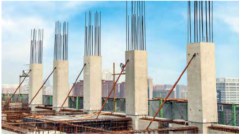
Figura 2.1: Columnas de concreto armado (Revista Cimientos, 2019)
