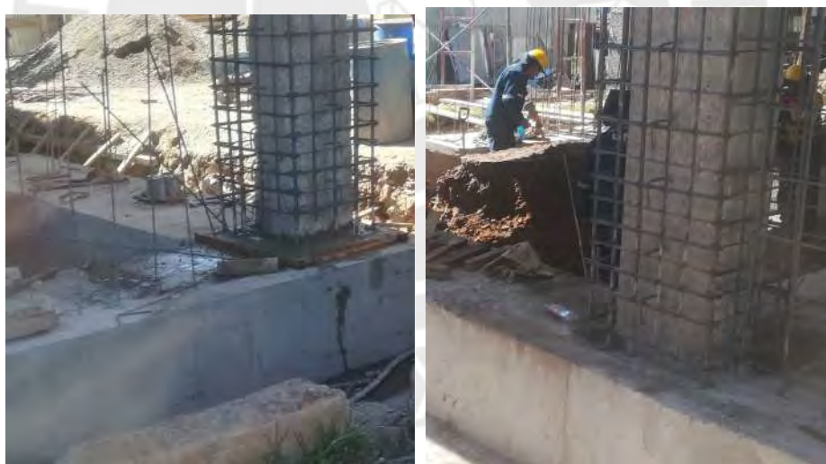
Figura 4.38: Reforzamiento de columnas y placas con encamisados de concreto armado
