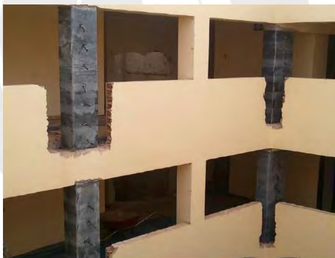
Figura 4.39: Refuerzo de columnas a confinamiento con SikaWrap ®600C y Anclaje de FRP. (SIKA, 2018)
