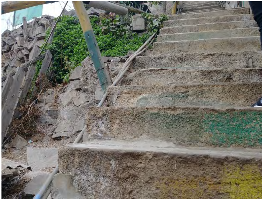
Figura 5.3 Mangueras en pasaje de escaleras que transportan agua desde avenida a la vivienda
