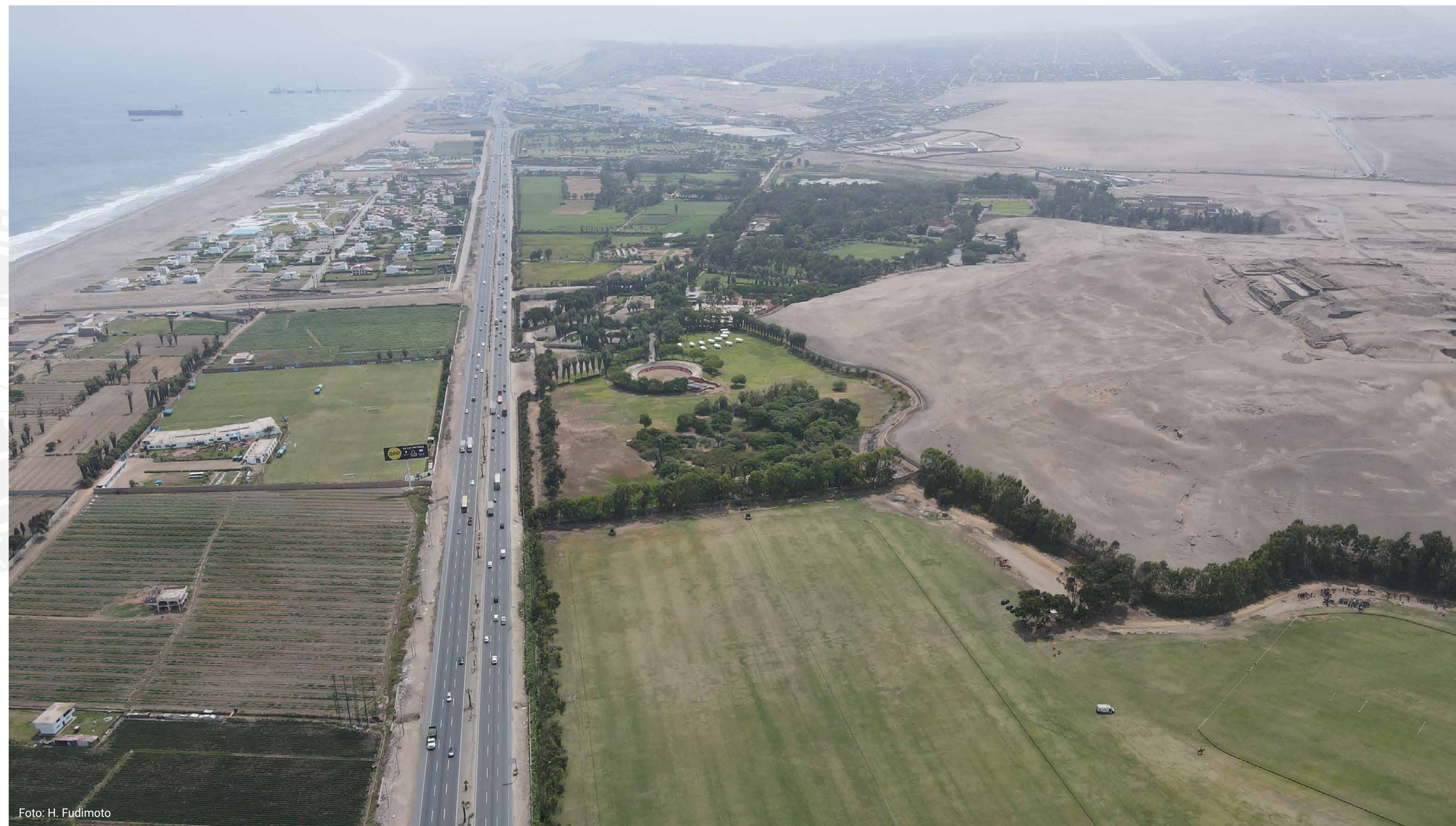
Desconexión total con el mar Construcción de la Nueva Carretera Panamerica SUR
