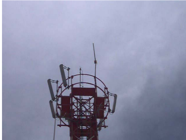
Figura 27 Pararrayo Franklin Sharp
