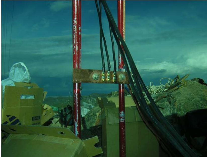
Figura 20 Aplicación de Barrajes de tierras
