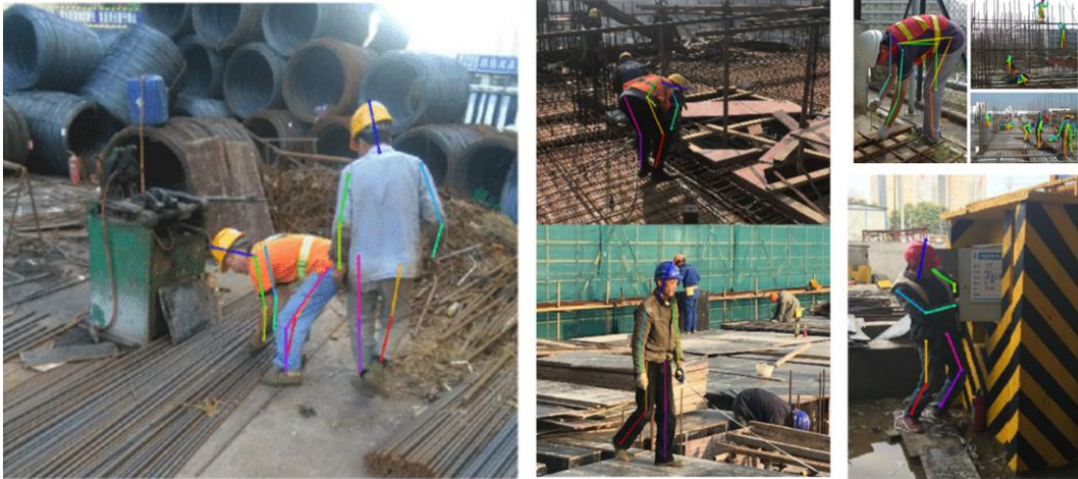
Figura 15. Ilustraciones de estimación de modelos esqueléticos 3D para identificar posturas inseguras.
