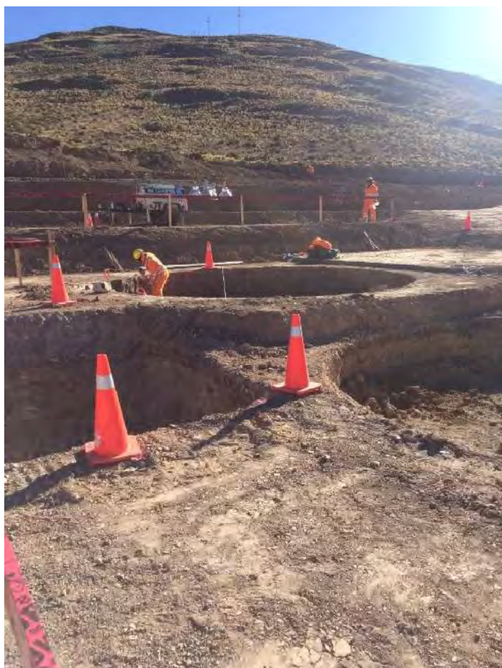
EXCAVACIONES PARA CIMENTACIONES
