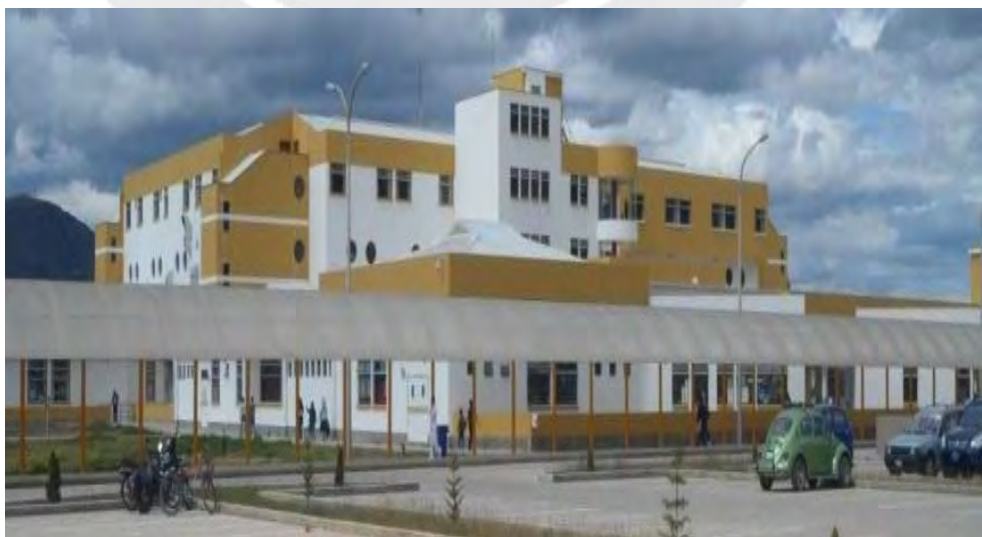
Figura 1. Hospital Regional Docente de Cajamarca.
