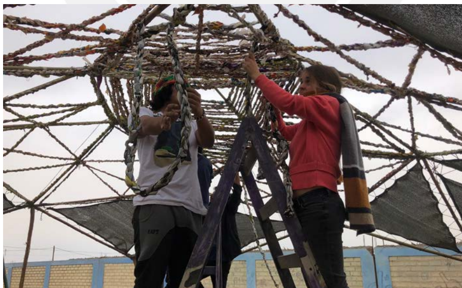
Figura 43: Proceso de construcción: Sujetar la malla Rashel en la caña de Bambú.
