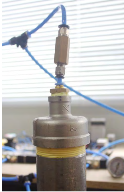
Figura 2: Vista del tope de columna ya armado y conexionado. Puede apreciarse de abajo hacia arriba; el tubo que forma el cuerpo de la columna, el teflón excedente y la tapa roscada, el conector neumático rápido y la estricción de orificio.
