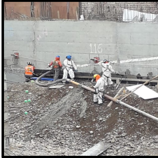
Fig 2.16. Vaciado de concreto con tubería. Fuente: Propia
