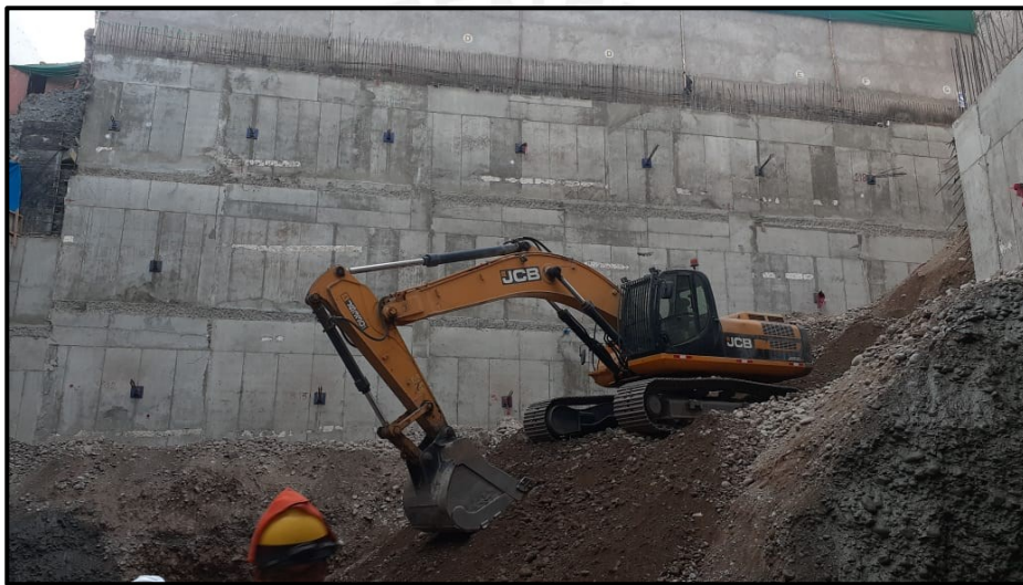
Fig 2.5. Proceso de excavación masiva de anillo. Fuente: Propia
