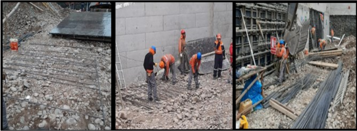
Fig 2.10. Armado de malla de refuerzo. Fuente: Propia
