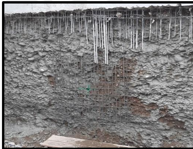
Fig 2.11. Punto de referencia para colocación de anclaje. Fuente: Propia
