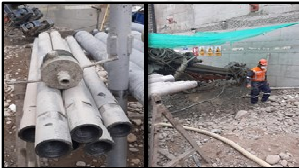
Fig 2.26. Cabezal de presión y colocación de presión. Fuente: Propia
