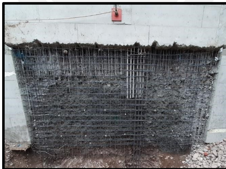
Fig 2.13. Dados de concreto colocados en malla de acero (puntos blancos). Fuente: Propia
