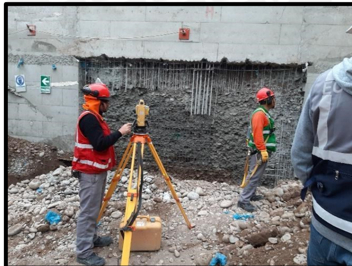
Fig 2.9. Verificación de ancho de muro y verticalidad. Fuente: Propia
