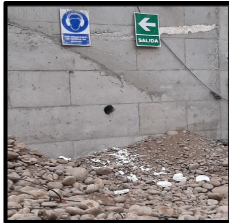
Fig 2.21. Muro desencofrado. Fuente: Propia
