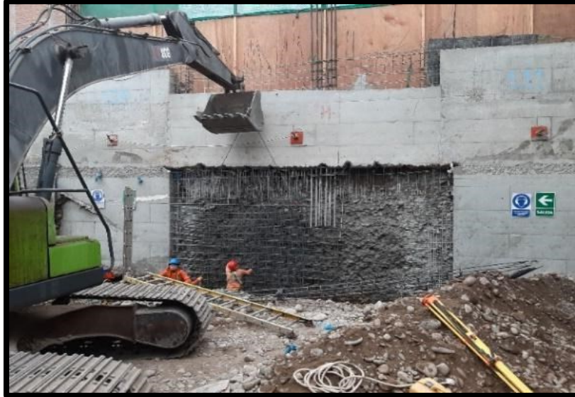
Fig 2.12. Izaje y colocación de malla de acero con maquinaria. Fuente: Propia
