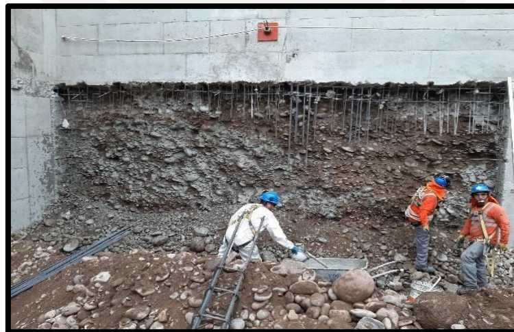
Fig 2.7. Aplicación de lechada. Fuente: Propia
