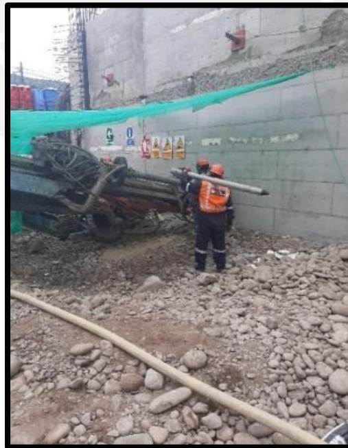
Fig 2.24. Tuberías colocadas. Fuente: Propia
