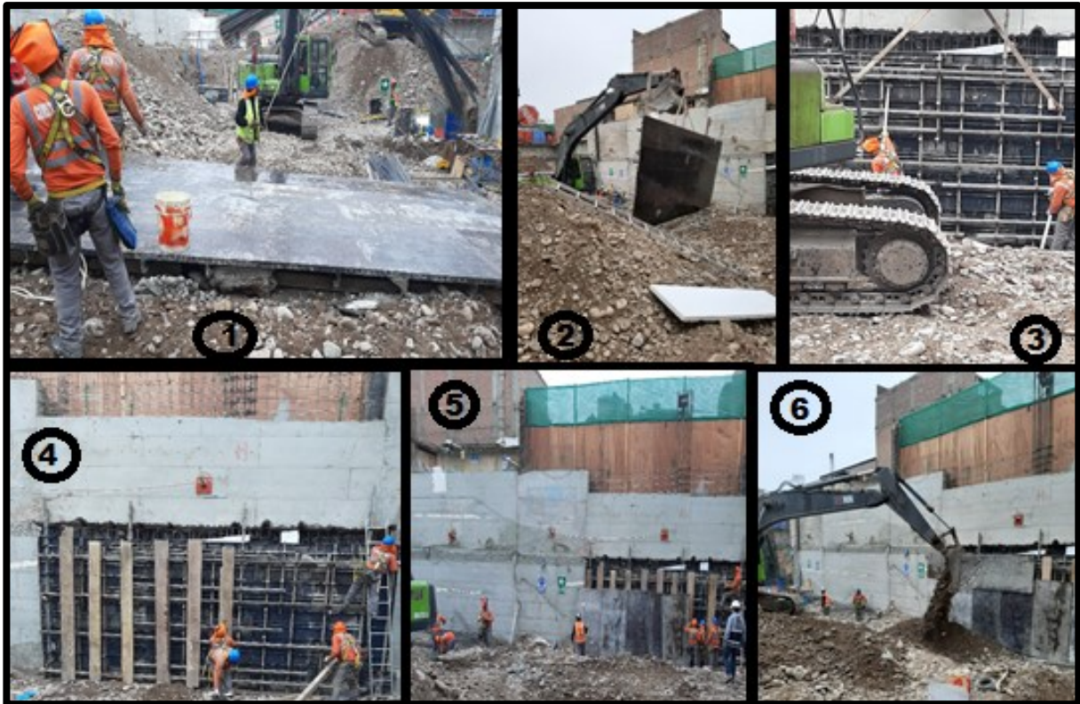
Fig 2.15. Secuencia para colocación de encofrado. Fuente: Propia
