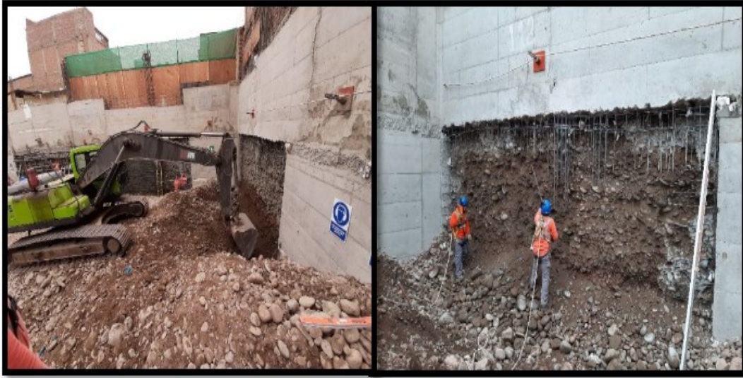
Fig 2.8. Perfilado a máquina y manual. Fuente: Propia
