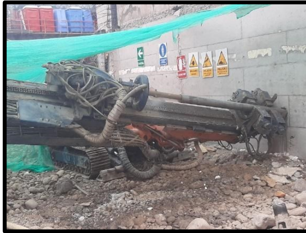
Fig 2.23. Perforación inicial. Fuente: Propia
